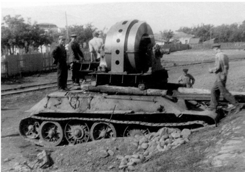
Рис. 71. Перевоз генератора на танке с товарной станции к ГЭС «Белый уголь». ПКМ.ОФ.2246/17.
