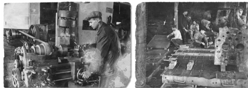
Рис. 13. В цехах Мотороремонтного завода. ПКМ.НВФ.16125, 16053.
