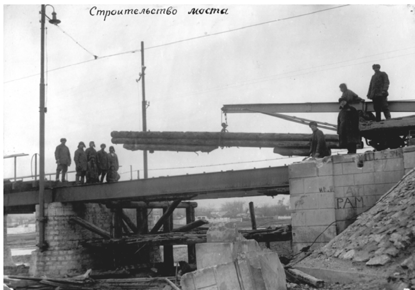
Рис. 58. Работы по восстановлению трамвайного моста через Подкумок. ПКМ.ОФ.157/2.
