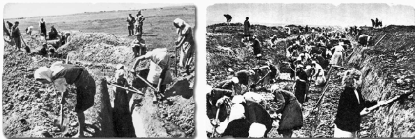
Рис. 19. На строительстве окопов и противотанковых рвов. Лето 1942 г. ПКМ.НВФ.16051, 16052.
