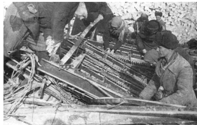
Рис. 43. Разборка разрушенного трамвайного парка. ПКМ.ОФ.321/12.
