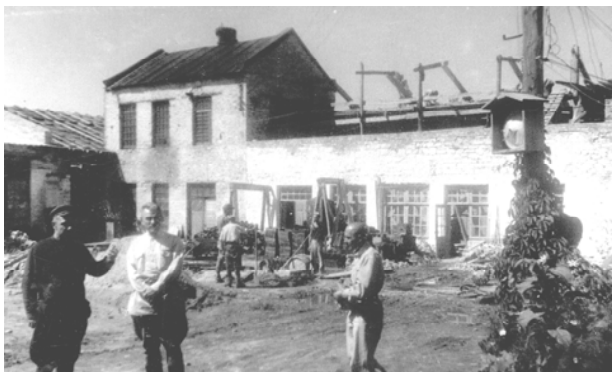
Рис. 63. Работы по восстановлению литейного цеха завода гаражного оборудования. ПКМ.ОФ.443/2.
