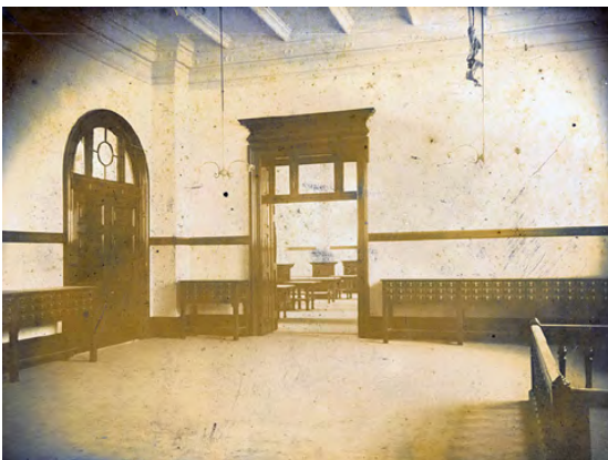
撮影:1906(明治39)年頃 旧:2階 目録室 現:2階 展示準備室、見学者控室 天井から配線が下がり、照明にも電球・ガラス笠がついていないので、完成前の写真と思われます。
