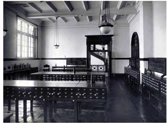
撮影：1929（昭和4）年頃 旧：2階 目録室 現：2階 展示準備室、見学者控室 目録室として使われていたこの部屋は、現在は間仕切りを作り、展示準備室、見学者控室となっています。
