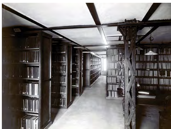
撮影：1906（明治39）年頃 旧：書庫 現：書庫 建物北側にある書庫。手前の鉄骨は上層の床を支えています。
