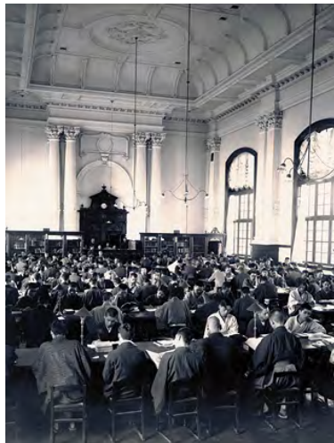
撮影：1906（明治39）年～1929（昭和4）年 旧：3階 閲覧室(明治期建築部分) 現：3階 本のミュージアム 創建時は「普通閲覧室」と呼ばれていました。和装の男性達が資料を利用しています。天井から下がっている照明は明治のもので、国際子ども図書館開館時の改修工事ではこのような写真を参考に復元されました。
