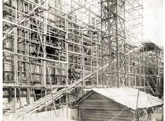
撮影:1902(明治35)年~1905(明治38)年 現在のレンガ棟の工事の様子。レンガを積み上げるための足場を組んでいるのがわかります。
