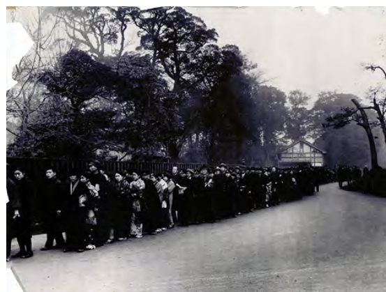
撮影：詳細不明 旧：表玄関 現：表玄関 閲覧室は定員制だったため、入りきれない利用者が外に行列を作って待っていました。
