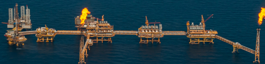
Plateforme pétrolière et gazière offshore à Campeche, Mexique.
