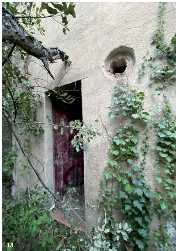
13 Restes de l'aiguada (costat via), amb la porta i l'orifici de sortida de la mànega per carregar d'aigua les locomotores (dreta).
