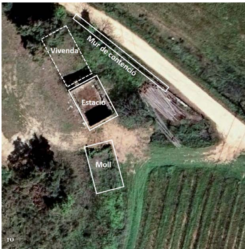
Restes visibles del complex de l'estació (Base cartogràfica ICGC / Ortofoto 2015)
