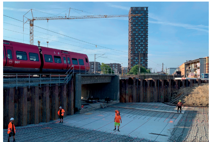
Anlægsarbejde omkring Nordvestpassagen.
