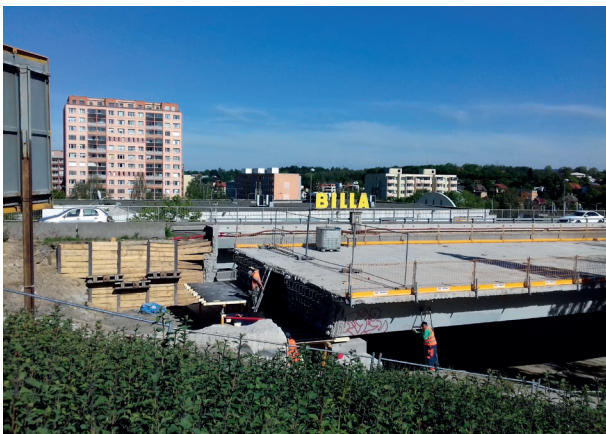
■ Rekonstrukce mostu v ulici Slánská
