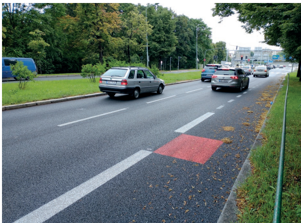
■ Nízkohlučný asfalt v průběhu vyznačování vodorovného dopravního značení
