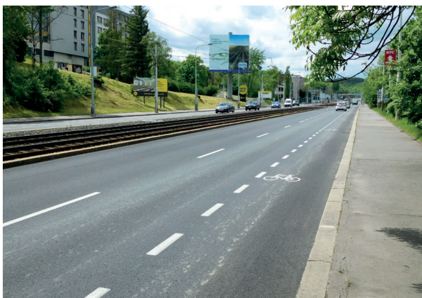
■ Nové vozovky ulice Plzeňská
