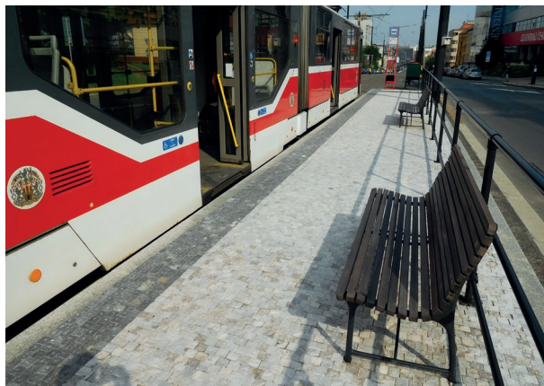
■ Úvratové obratiště tramvají Pankrác
