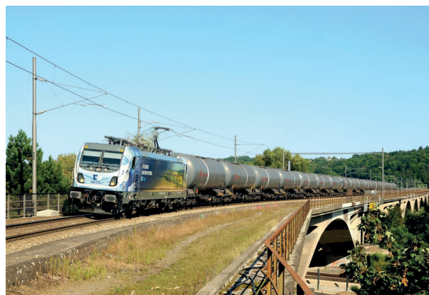
■ Přeprava po železnici má budoucnost
