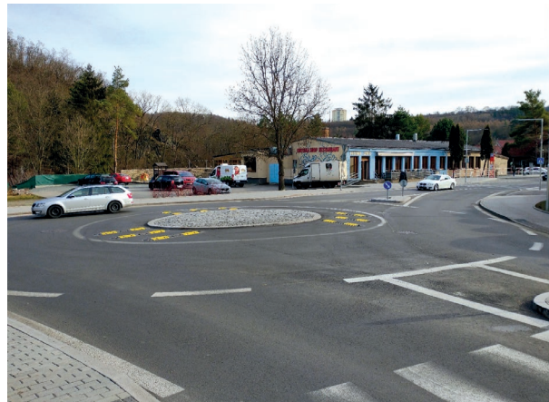
■ Výstavba kruhového objezdu v křižovatce Horoměřická – Nebušická
