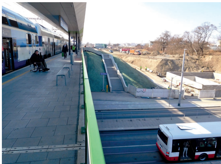
■ Pohled na obě úrovně nástupišť
