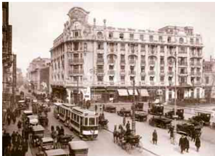
Athénée Palace, Calea Victoriei Construit de arhitectul Théophile Brateau, a fost transformat și modernizat în 1937 de arhitectul Duiu Marcu.
