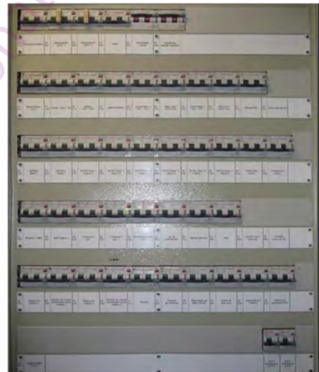
Figura 1-23. Panel de magnetotérmicos.
