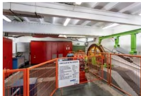
Figuras 1.12 y 1.13. Funicular. ↖ Izquierda: polea que transmite el movimiento al cable del Funicular de Vallvidrera. También se aprecia la mordaza del freno. ↗ Derecha: sala de máquinas en la que se alojan el motor y la polea. 📷 FGC
