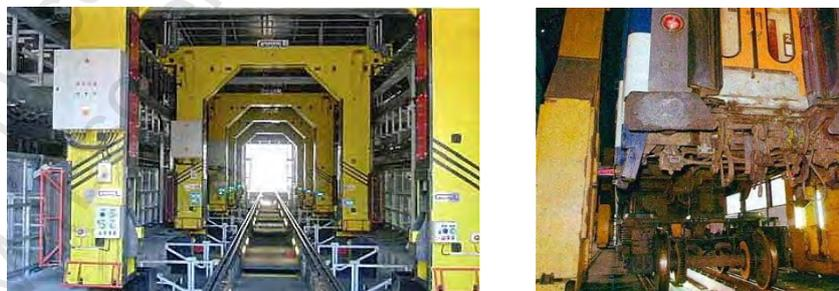
Figura. 4-2 Instalaciones para cambio de bogies de diferente ancho
