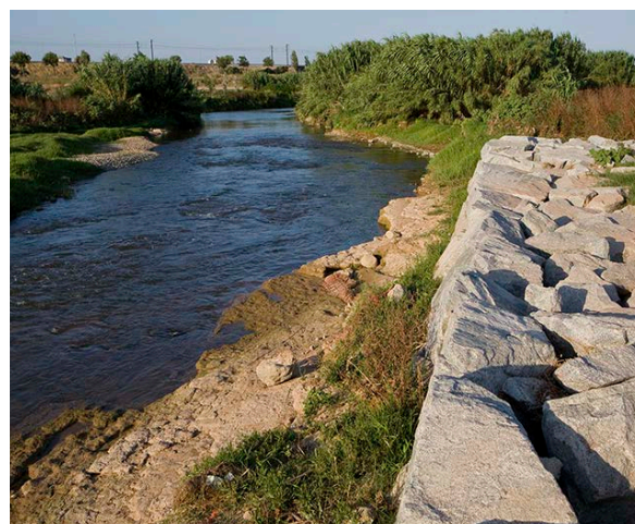
Exemple de deflector, una de les actuacions d'AMB per restablir l'equilibri ecològic del riu
