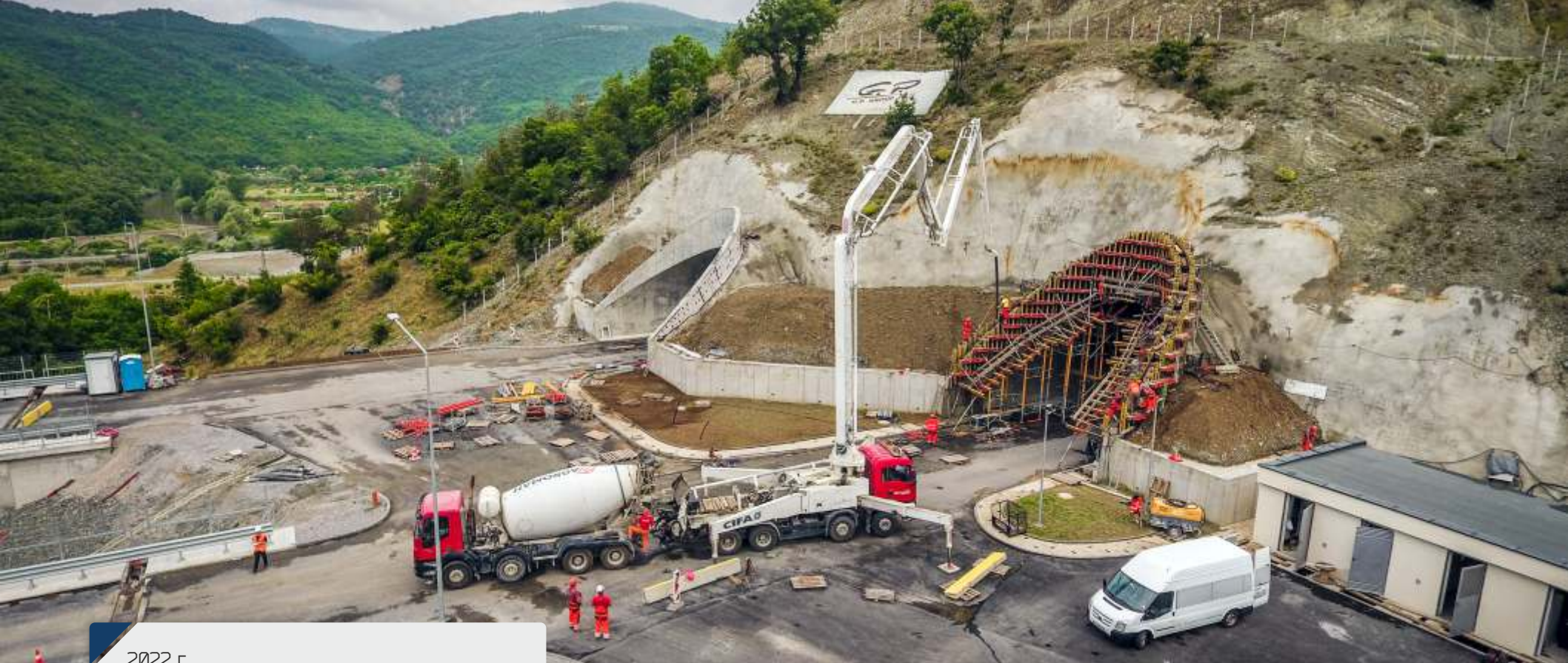
2022 г, строителството на тунел „Железница“ АМ „Струма“ Лот 3.1.2
