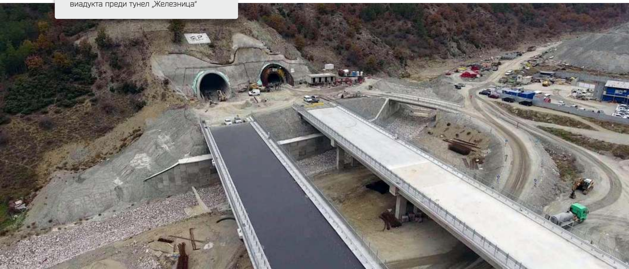
2021 г. строителството на виадукта преди тунел „Железница“
