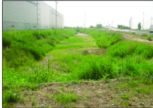
Polígon Prologis. Detall de rasa que recull les aigües pluvials i que té capacitat d'emmagatzematge.
