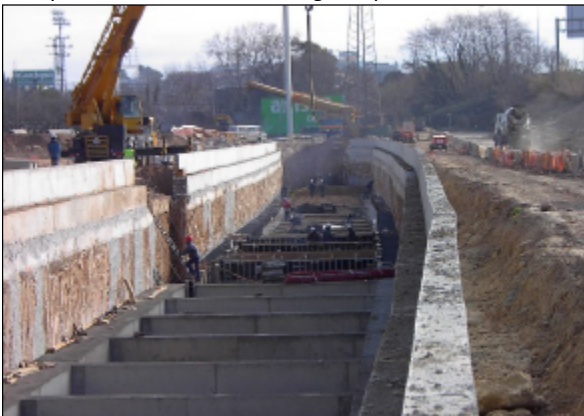
Dipòsit de laminació d'aigües pluvials de la Ciutat Esportiva Joan Gamper (en construcció). Font: TYPSA.
