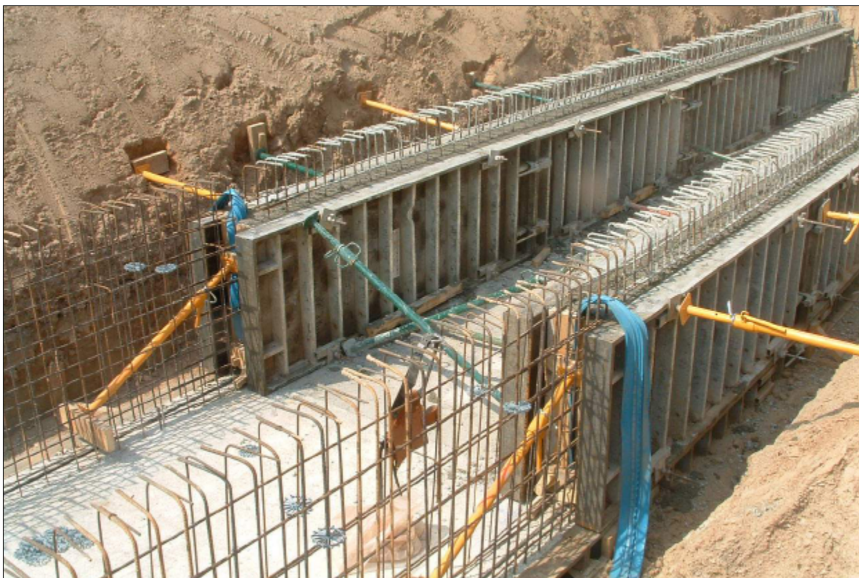
Obres del col·lector de desguàs d'aigües pluvials al canal lateral de l'autopista a Sant Joan Despí.
