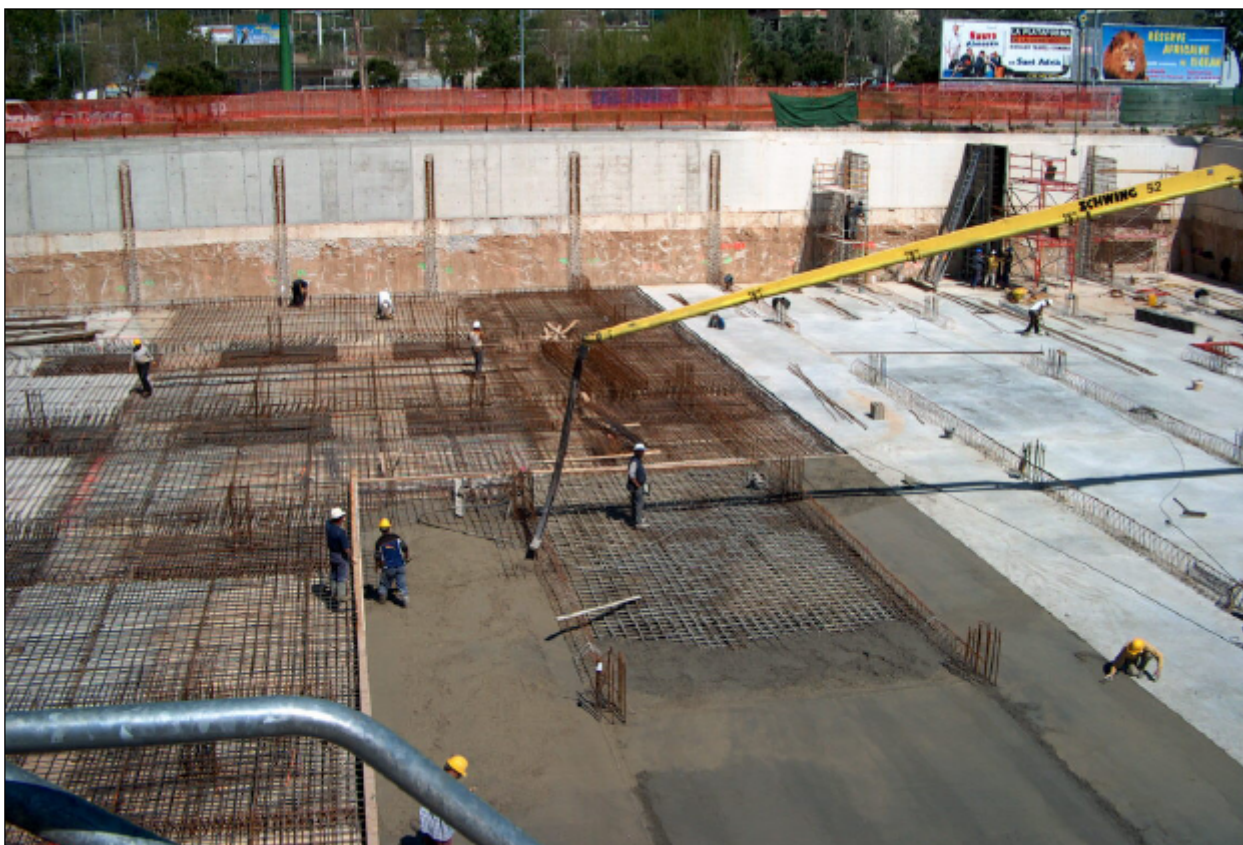
Dipòsit d'aigües pluvials del Camp de l'Empedrat (en construcció) a Cornellà. Obra proposada pel PDAP.
