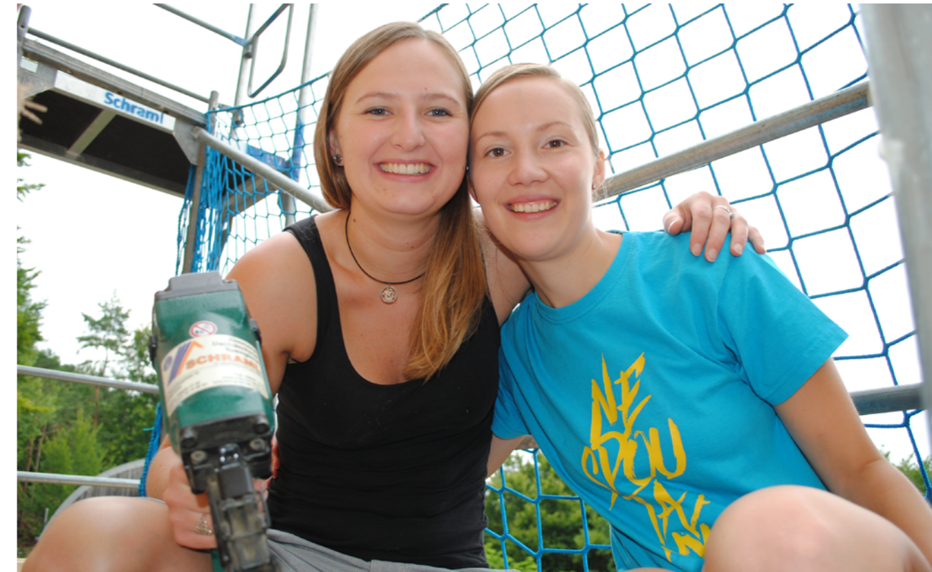
Am Knappenberg bei Sulzbach-Rosenberg errichteten Jugendliche unter dem Projekt „Jugend baut Kirche“ eine Holzkapelle in Eigenregie. Mit vereinten Kräften wurde gesägt und gezimmert, bis die Kapelle im November 2017 eingeweiht werden konnte.
