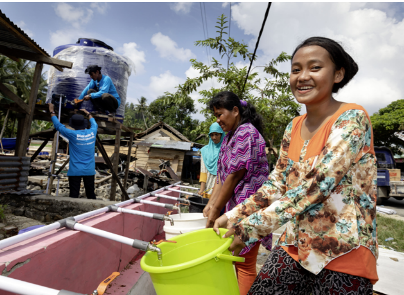
In dem indonesischen Dorf Lende Tovea ist mithilfe von Spendenmitteln eine Nutzwasserversorgungsstelle für die Menschen entstanden.
