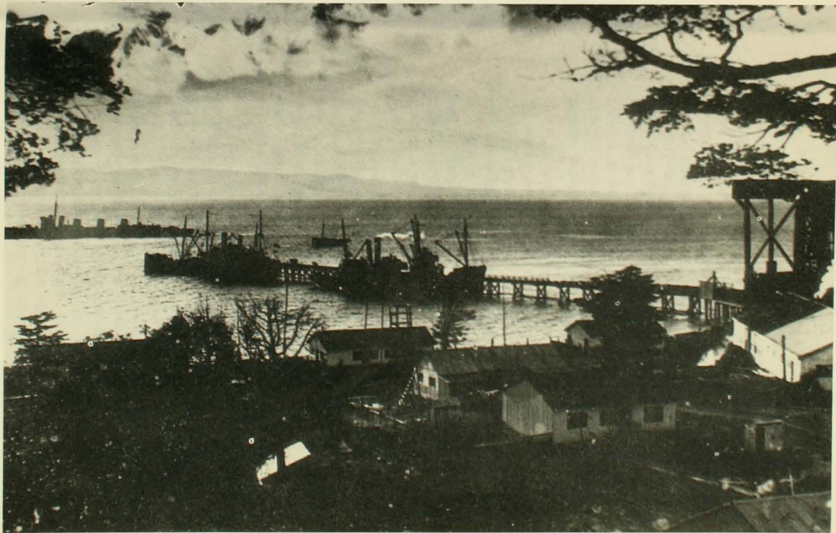
Aspecto del muelle y de parte del poblado del yacimiento carbonífero de Mina Elena hacia 1943.
