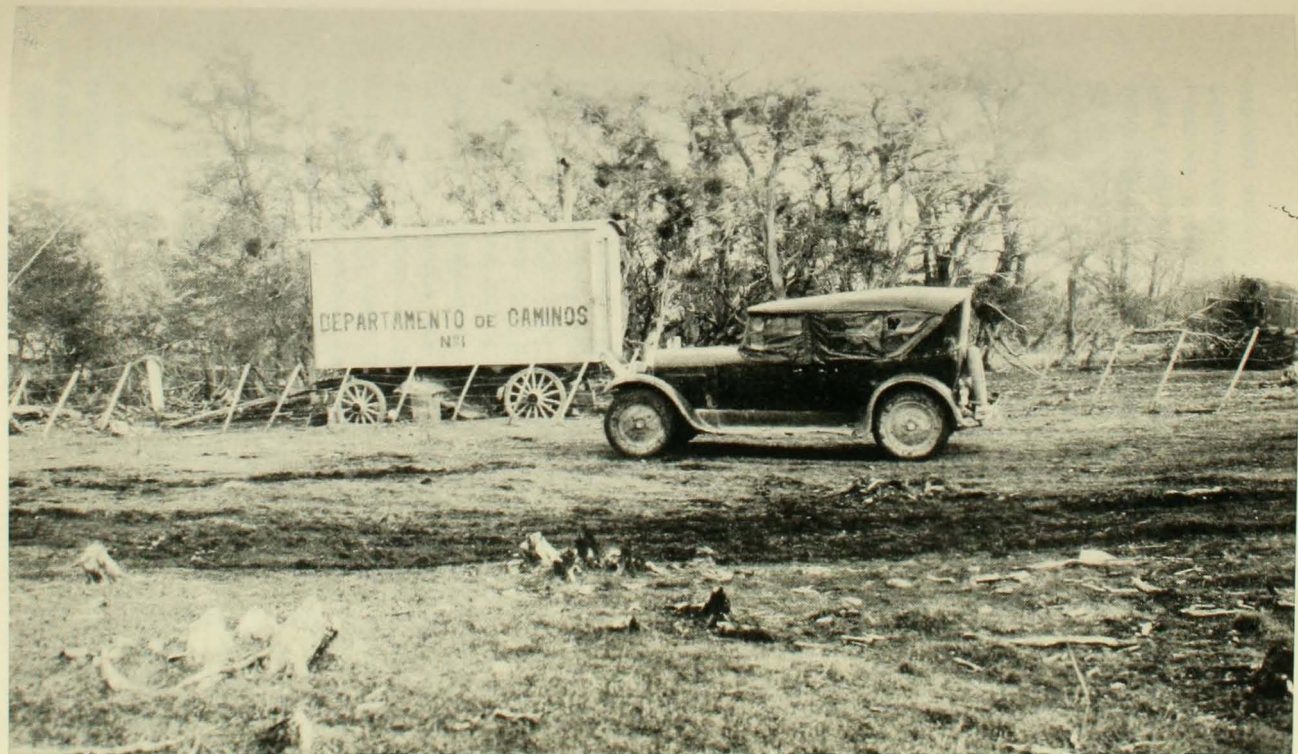
Puesto de inspección en la zona de Río Tranquilo durante la construcción del camino entre Morro Chico y Puerto Natales (1930).
