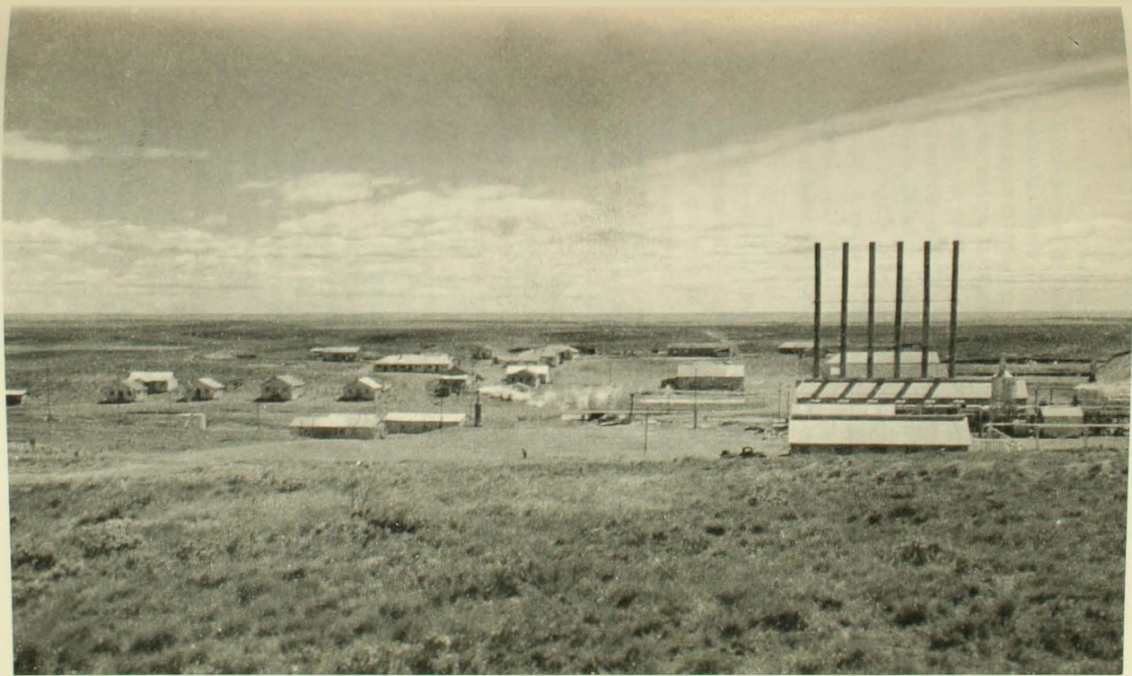
Aspecto del campamento petrolífero Cerro Manantiales, Tierra del Fuego, hacia 1950. En primer plano instalaciones de la refinería. Fotografía Alberto M. De Agostini
