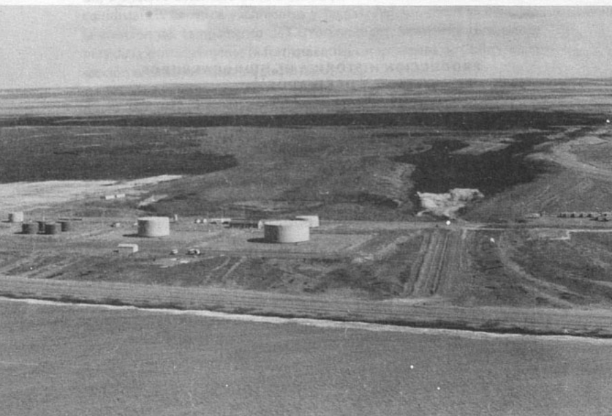
Batería de Recepción de Crudo Costa Afuera en Punta Catalina (1979)
