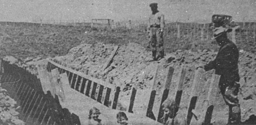
El ganadero Pedro Arentsen dirigiendo la construcción del baño en su estancia "Sylvia"
