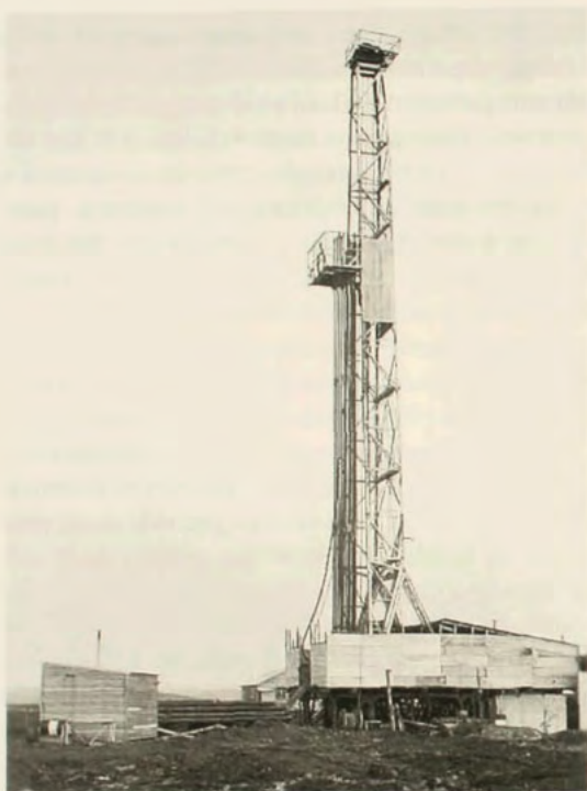
Equipo de perforación N° 1 de la CORFO en actividad en Tierra del Fuego.
