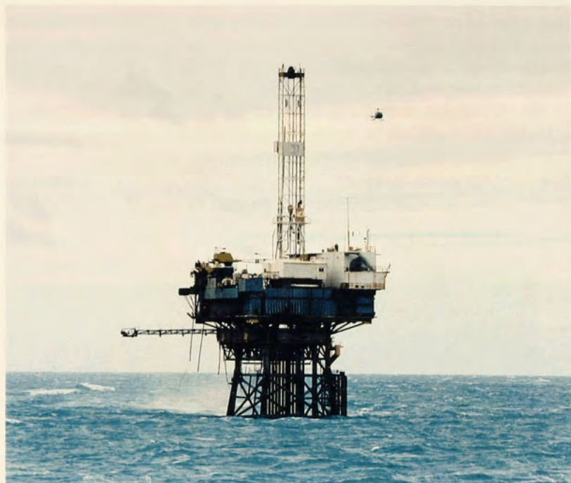
Equipo M-10 en faena de perforación.
