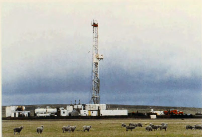
Equipo de perforación en Tierra del Fuego.
