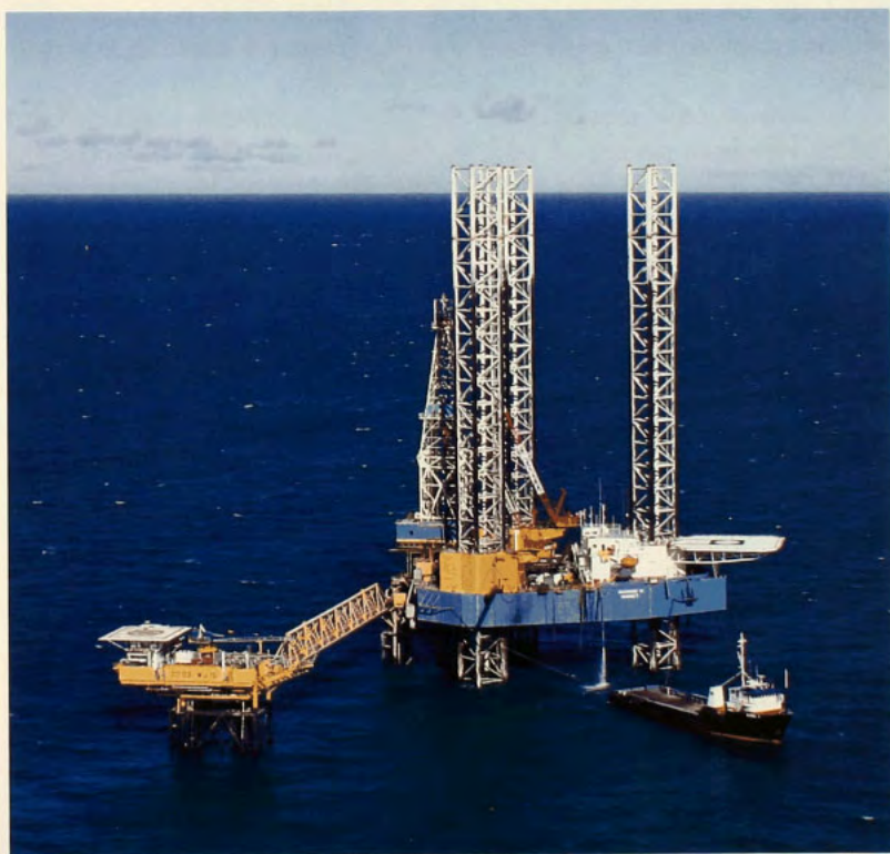
Plataforma de perforaciones Nuggett.
