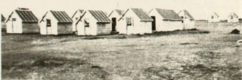
Aspecto del primer campamento de trabajo en Springhill (1945).
