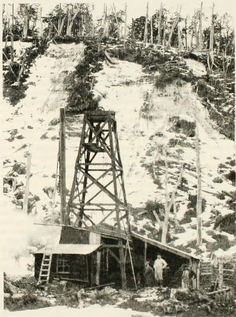
Torre de perforación en sondaje de mantos carboníferos en el Valle del Río de Las Minas, 1899. Semejantes debieron ser los equipos empleados en la búsqueda inicial de hidrocarburos.
