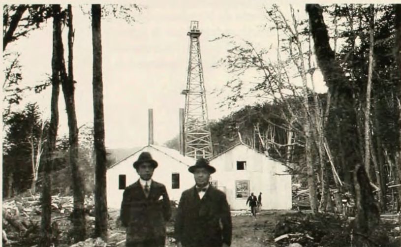
Otro aspecto del pozo R-2 de Tres Puentes.
