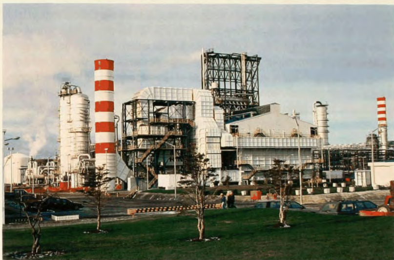
Vista de parte de las plantas de metanol que integran el complejo industrial de Cabo Negro.
