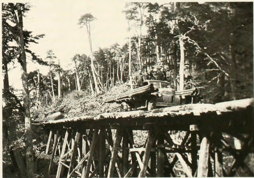
Forma en que se transportaban los tubos hacia 1940.
