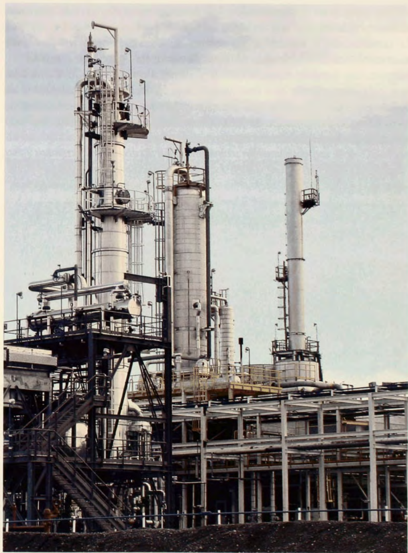
Aspecto de la refinería de San Gregorio.
