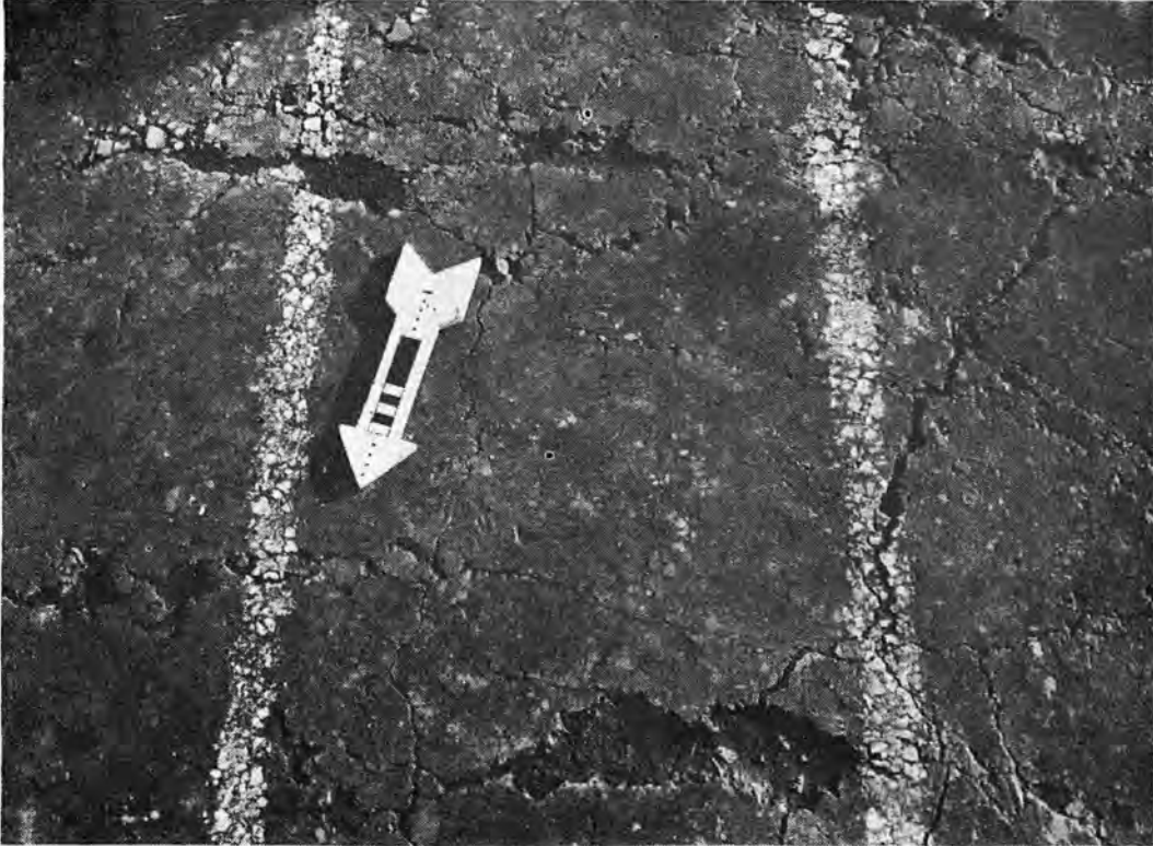
2. Terrazzo döşeme yakından A detail of the terrazzo flooring
