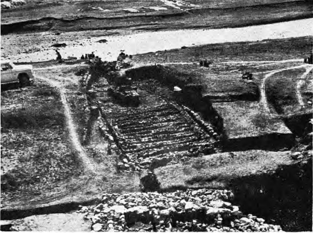
1. Izgara planlı temel, güneye doğru; ön planda hücre planlı bir temel parçası (bk. lev. 43)
