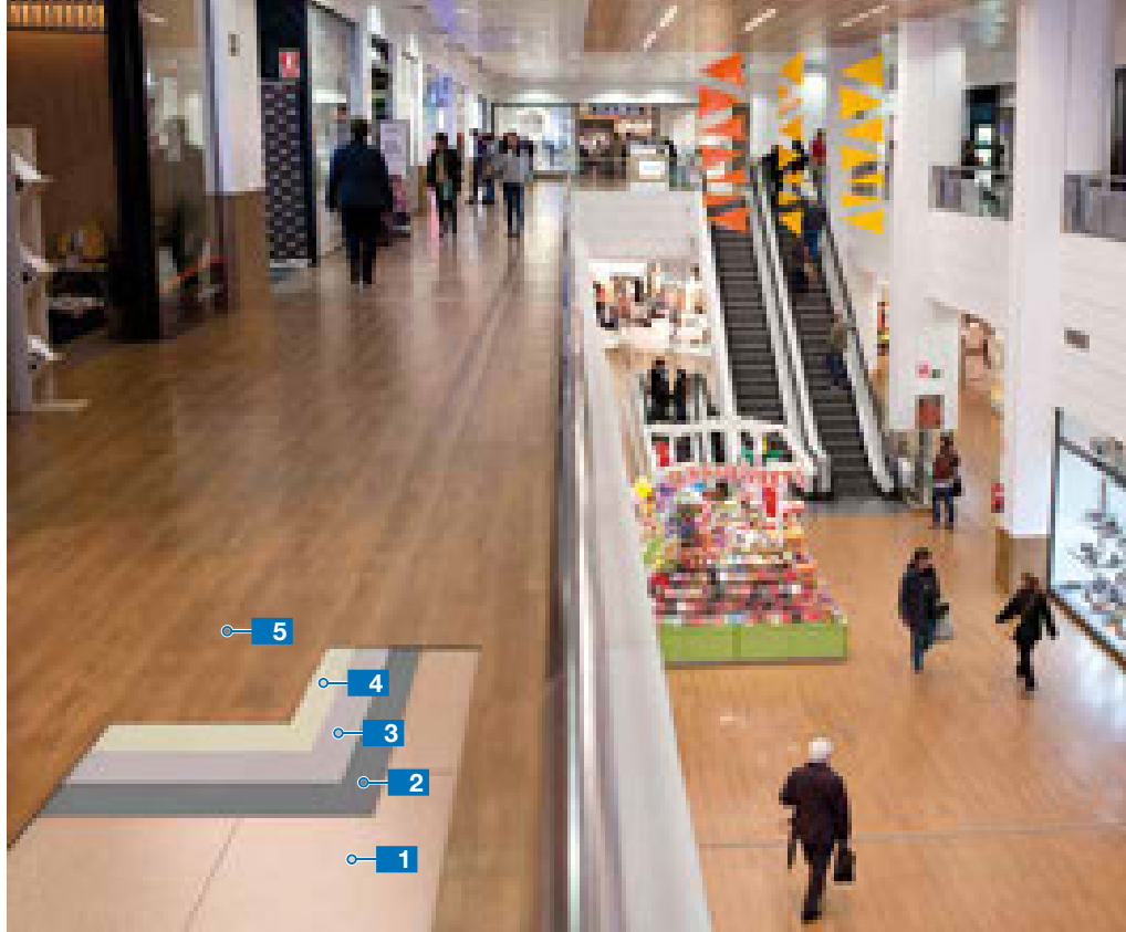
Posa di LVT ("Luxury Vinyl Tiles") da incollaggio su pavimentazione ceramica esistente Glue-down LVT ("Luxury Vinyl Tiles") installation on existing ceramic floor
