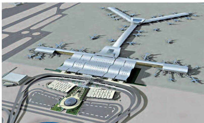
ドーハ新国際空港の二相鋼製の屋根（出典：Qatar Airways社）
