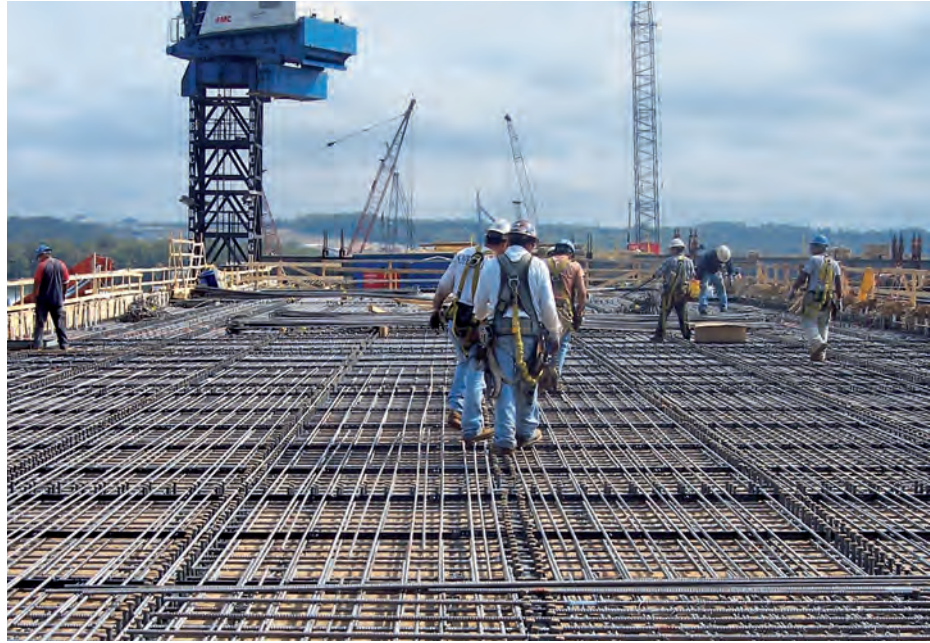
大型橋への二相鋼鉄筋の適用 (出典：Hardesty & Hanover, LLP)
