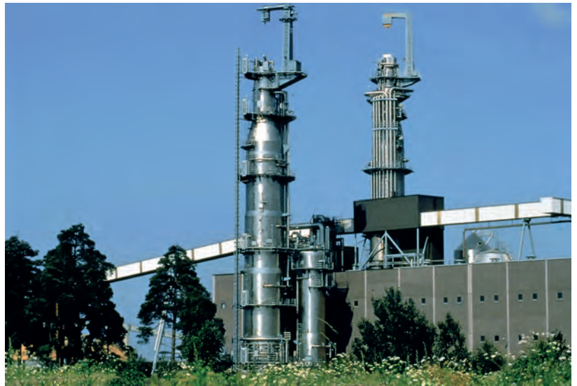
2205 連続硫酸塩パルプ蒸解装置および含浸タワー(Sodra Cell Mönsterås) スウェーデン (出典：Kvaerner Pulping)
