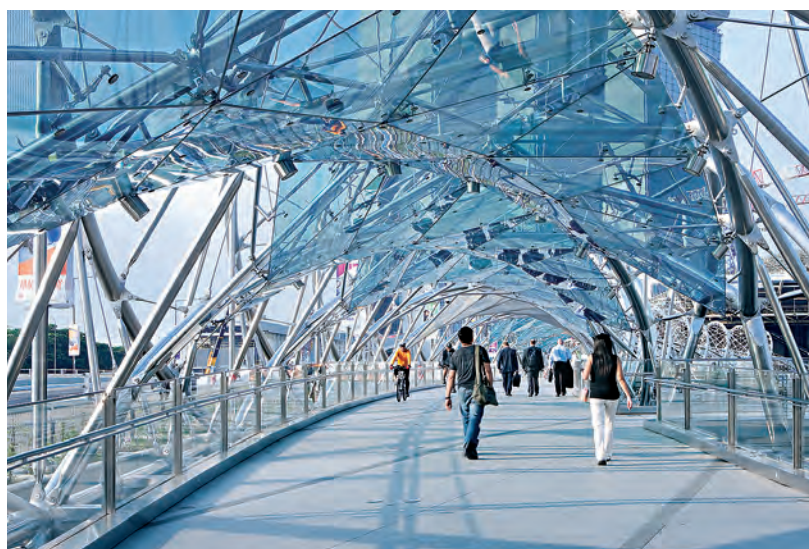
全ての構造が2205二相鋼のシンガポールのヘリックス橋（撮影：Christopher Frederick Jones氏）
