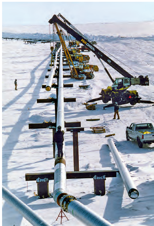
Messa in opera di un tubo coibentato da 24" in EN 1.4462 (2205) su supporti verticali nella Prudhoe Bay (Fonte: Arco Exploration e Production Technology)
