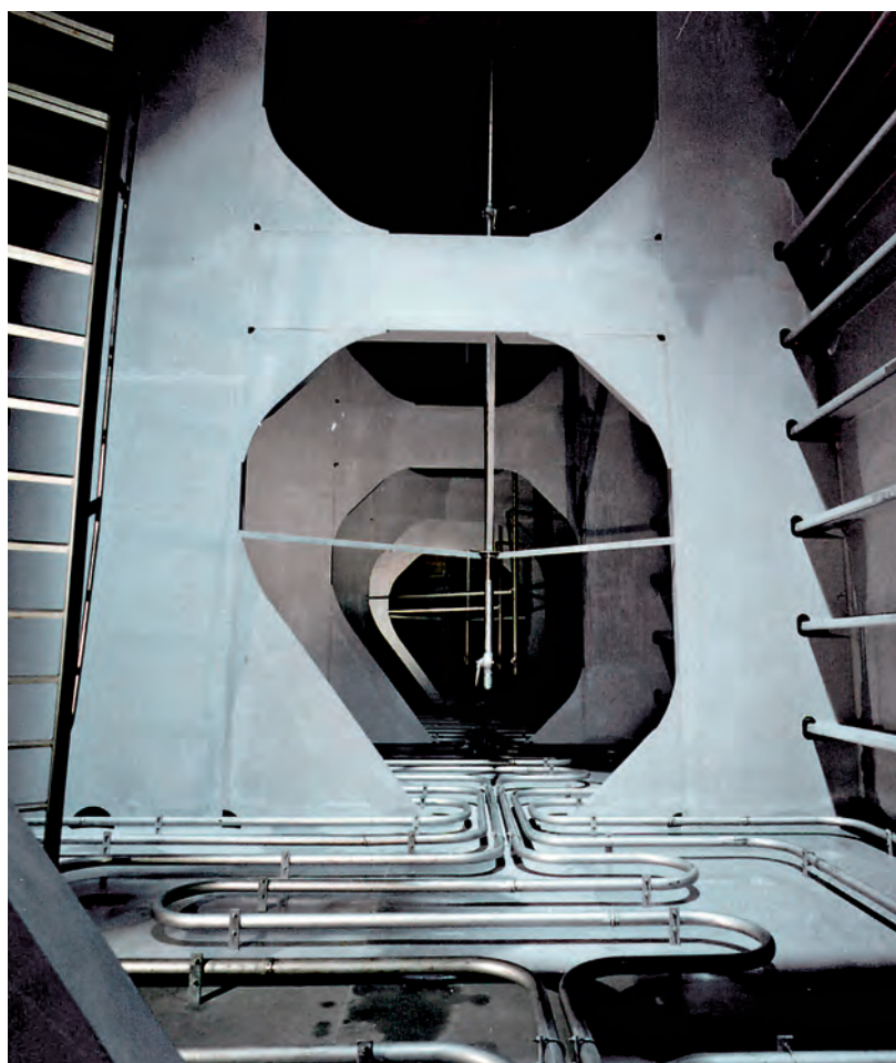
Interno di un serbatoio in EN 1.4462 (2205) di una nave cisterna (Fonte: ThyssenKrupp Nirosta)
