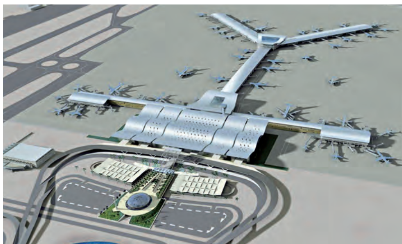
Aeroporto Internazionale New Doha con tetto in acciaio duplex ( Fonte: Qatar Airways)
