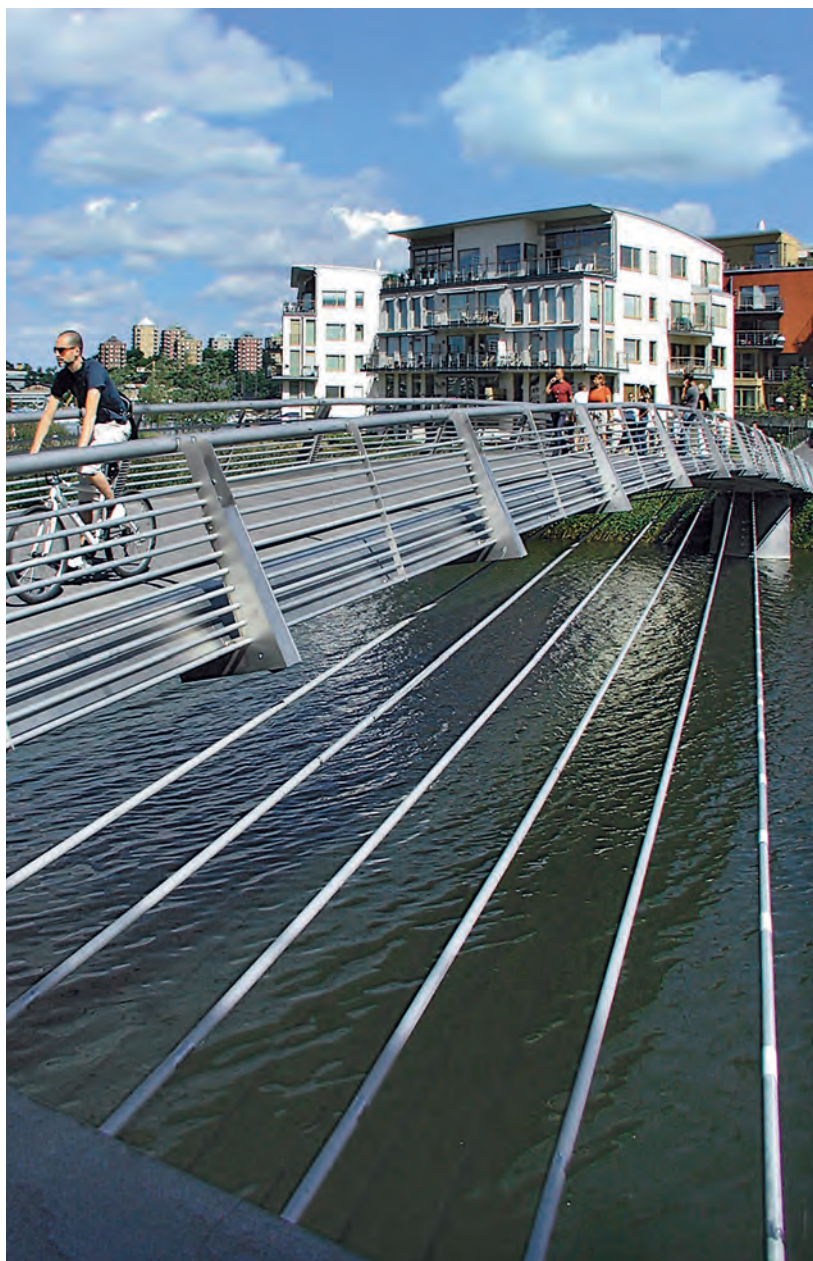
Ponte in acciaio inossidabile duplex, Stoccolma, Svezia (Fonte: Outokumpu)
