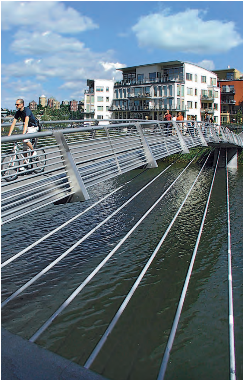
Puente de acero inoxidable dúplex en Estocolmo, Suecia (Fuente: Outokumpu)
