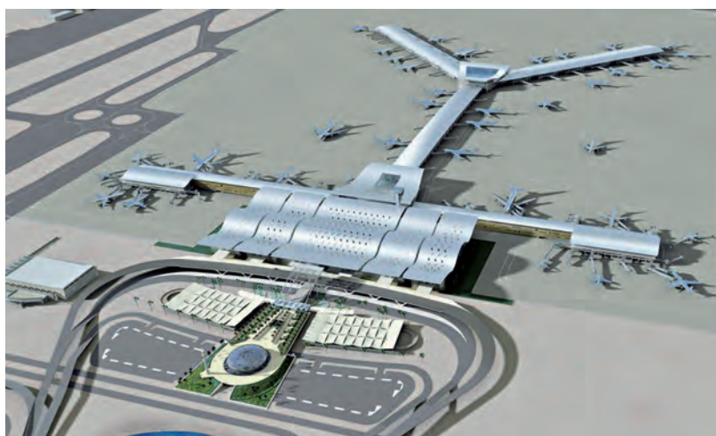
Aeropuerto internacional de New Doha con tejado de acero inoxidable dúplex (Fuente: Qatar Airways)
