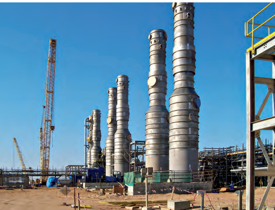
Equipos de recuperación de petróleo optimizados en acero inoxidable EN 1.4410 (2507) (Fuente: Aquatech)
