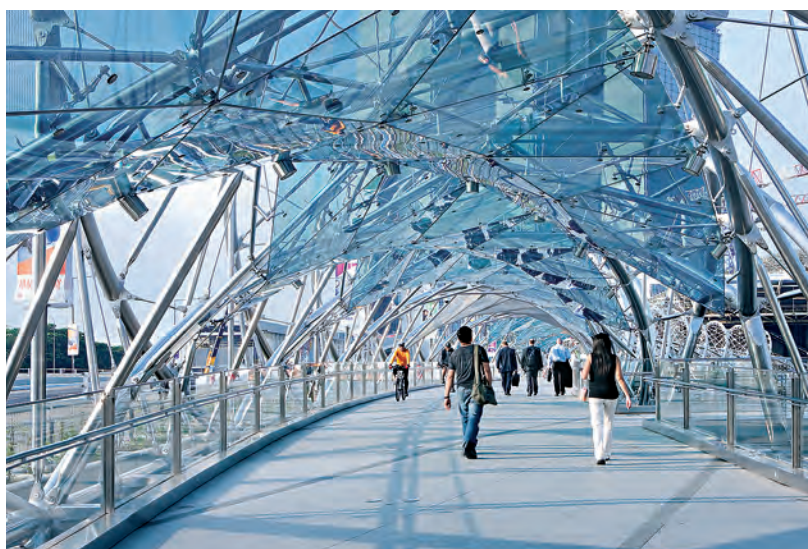
"The Helix", Singapur, con una estructura resistente de acero duplex EN 1.4462 (2205) (Fuente: Financial Dynamics/C. F. Jones)
