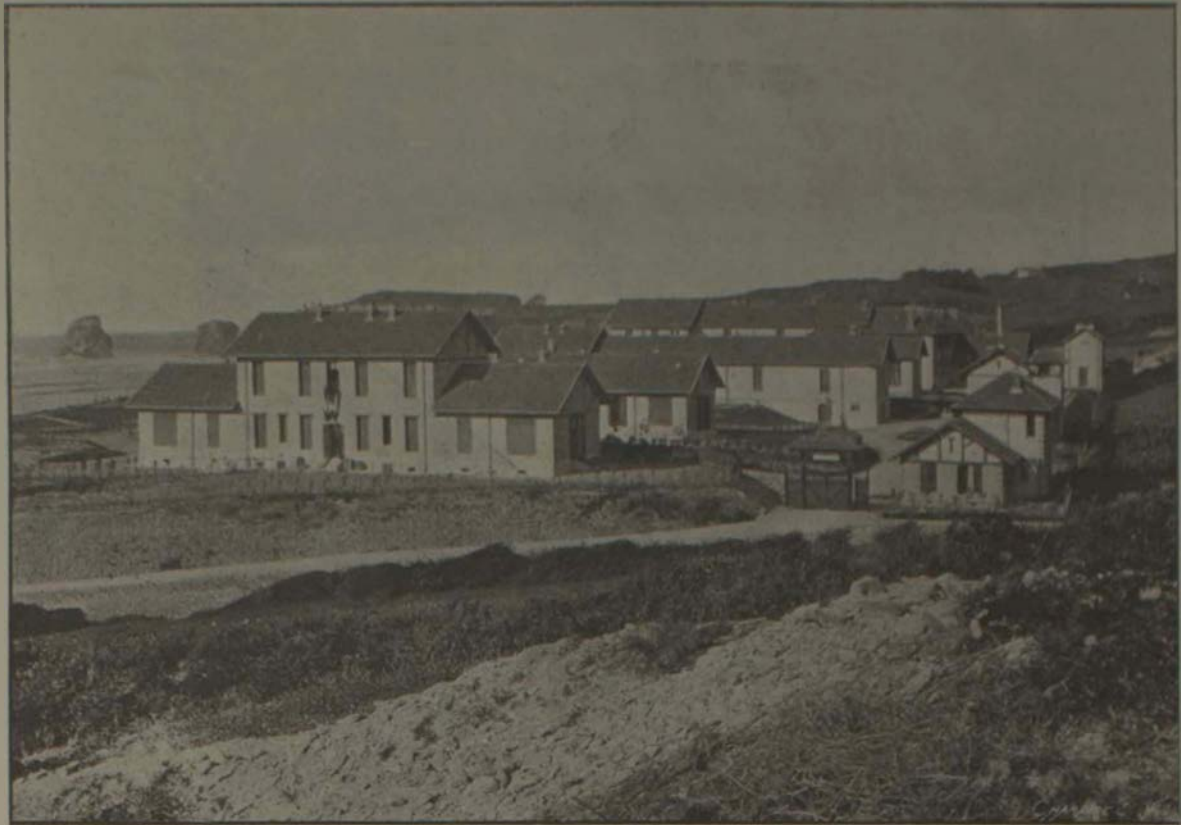
Le nouveau Sanatorium de la Ville de Paris, à Hendaye.
