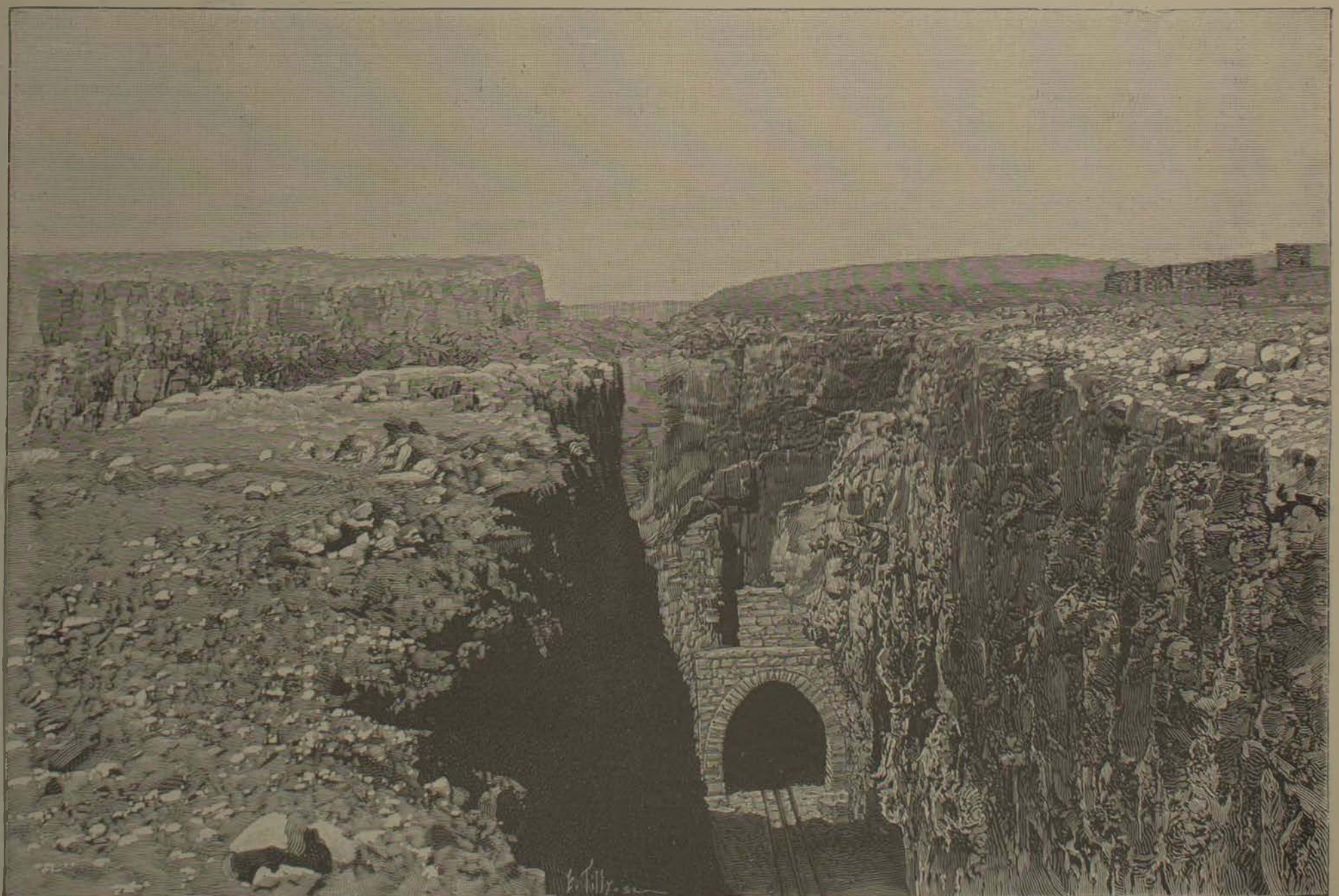
Tunnel sur la ligne de Durban à Johannesburg.
