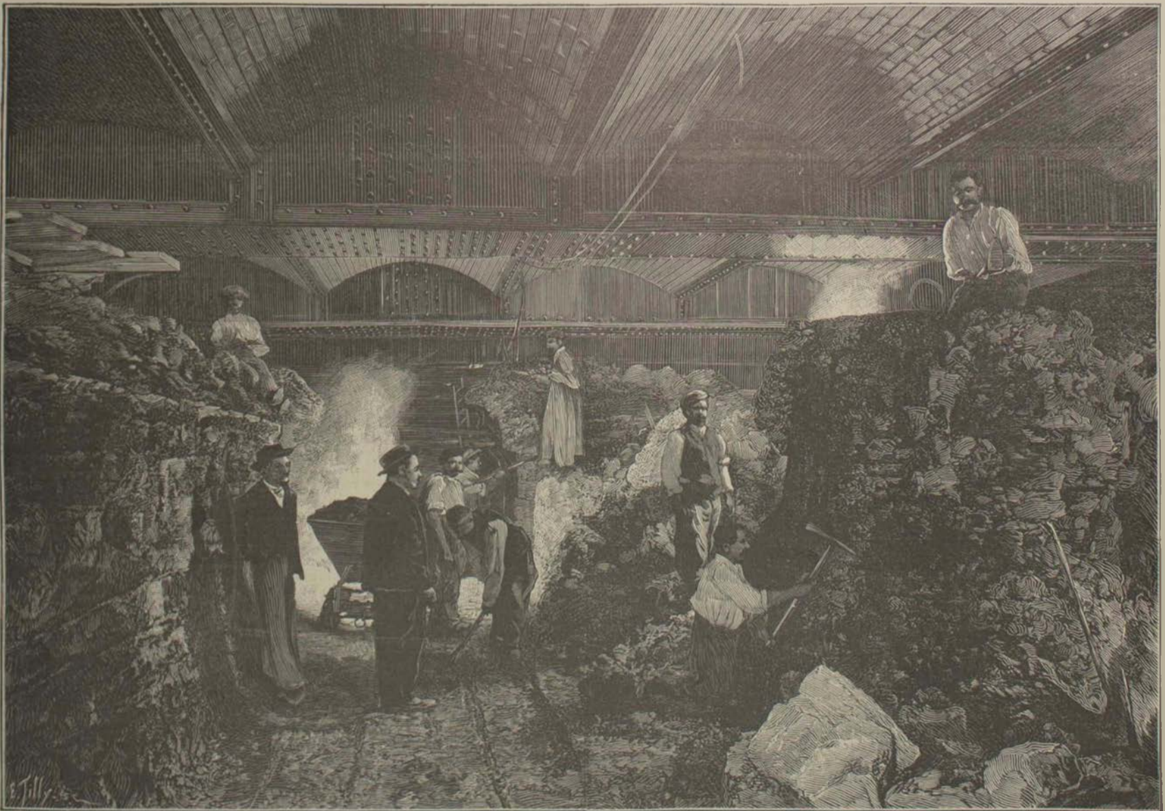
Les travaux de la gare du Palais-Royal.— (Photographies H. C. Godefroy.)
