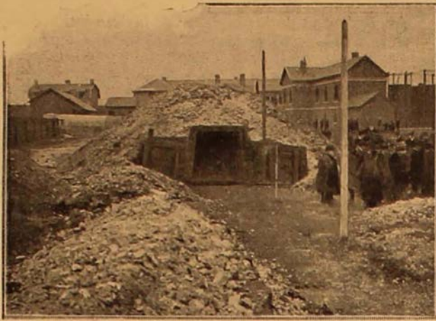
Issue de la galerie d'expériences par où sortent les flammes et les fumées.
