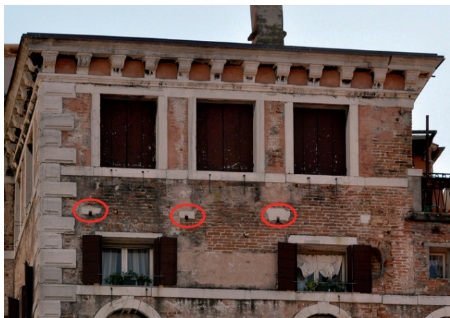
Una facciata con i blocchetti in pietra posti tra un piano e l'altro, a cui sono agganciati i tiranti metallici.
