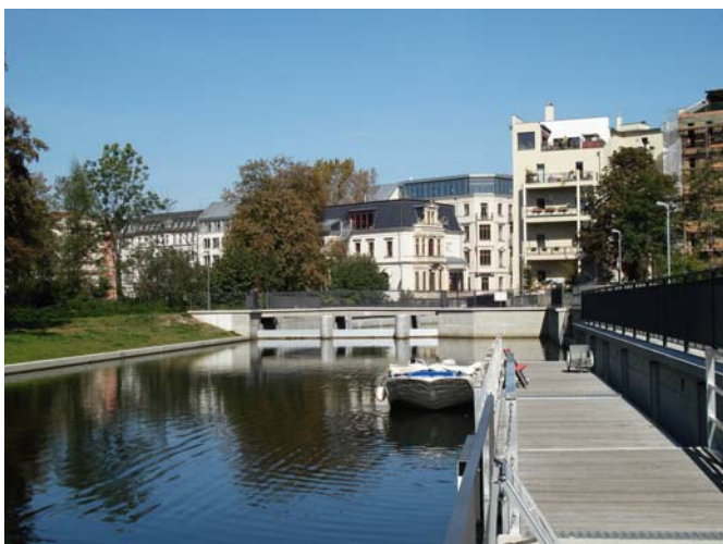
Außenmole des Stadthafens im Ortsteil Zentrum-West Foto: Thomas Martin
