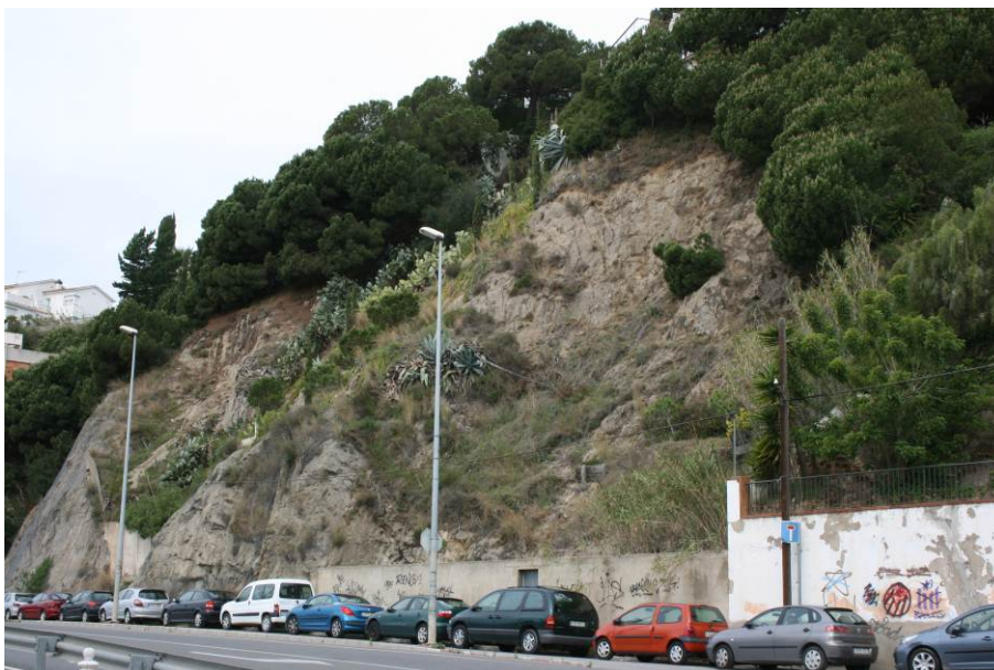
Fotografia 6. Tram A2 del talús de la Torre del Moro
