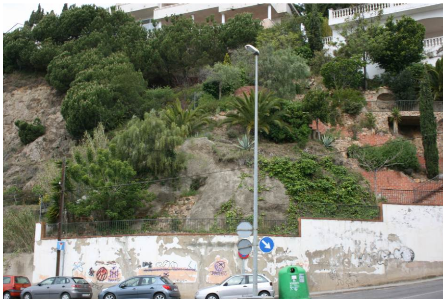
Fotografia 5. Tram A1 del talús de la Torre del Moro
