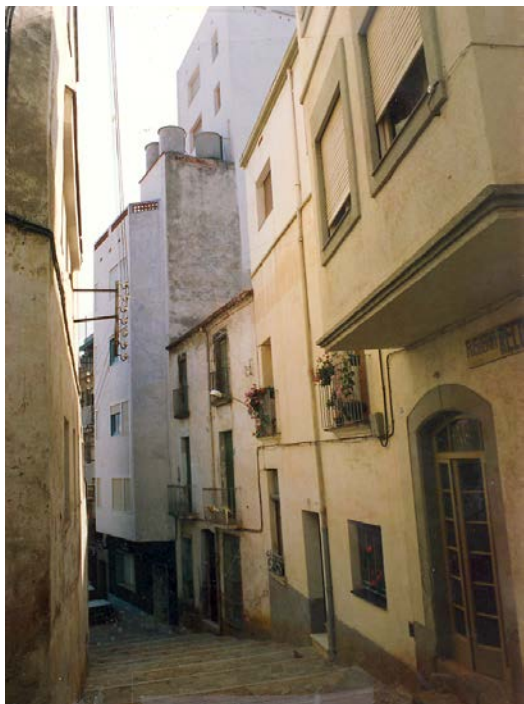
- La transformació de "la Davallada" vista des d'amunt.-
