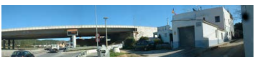
- La mala imatge de les edificacions afectades i no expropiades per nus de l'autopista.-
