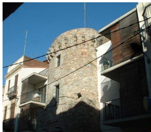
- La torre del carrer Ample restaurada.-
