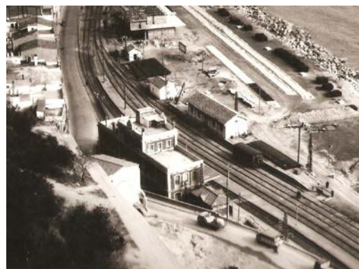
- Afectació incompleta de cases per a les obres de 1967.-
