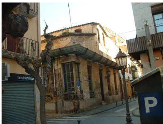
- "Can Cases" a la cantonada dels carrers d'en Riera i d'Avall,-
