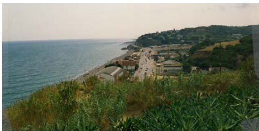
- La carretera N-II des del Cementiri.-
