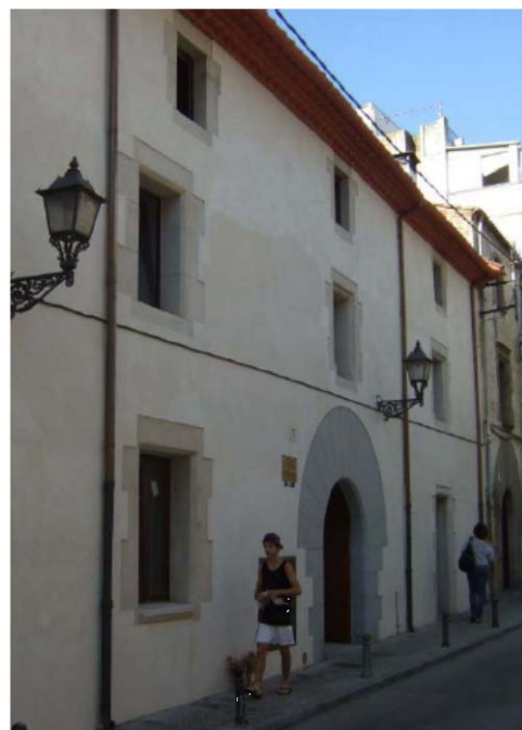
- Façana de Casa Pascual o Can Manel Recader, abans i després de la restauració.-
