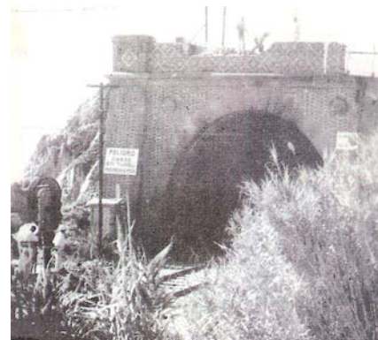
- L'enderrocament de les boques del túnel.-
