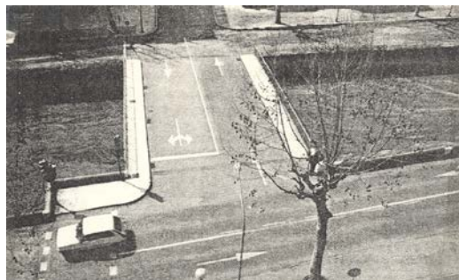
- “pont nou” dels anys 80 a la part alta de la Riera (fragment del cobriment d'aquesta).-
