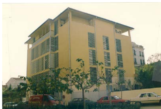
- L'edifici dels Jutjats dels anys 80.-
