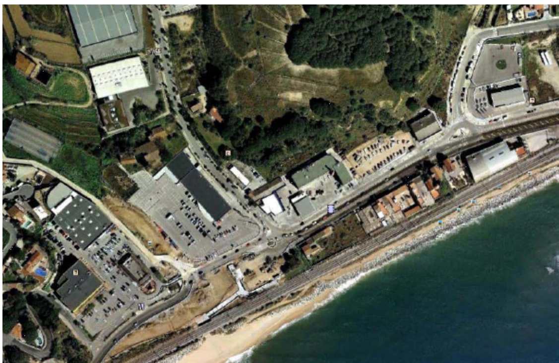
- L'eix de la carretera N-II de Sapí al Rial Llarg.-
