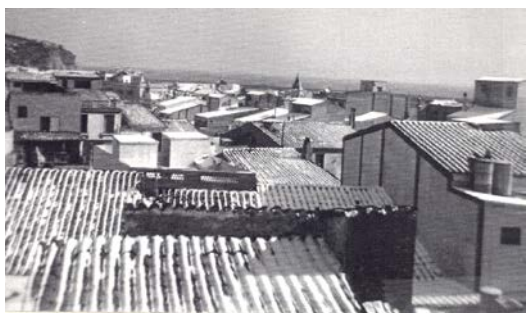
- Les teulades d'Arenys durant la nevada de 1962.-
