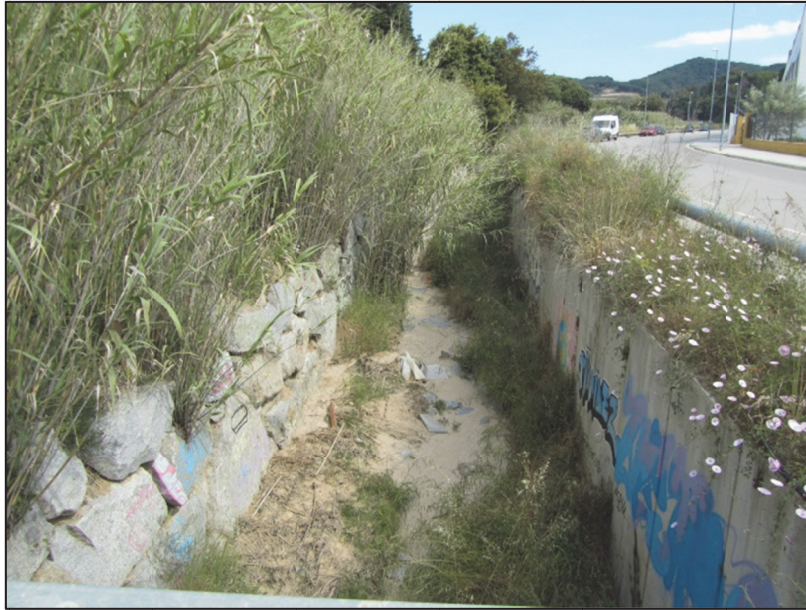
Figura 83. Canalització del rial de Cal Misser al polígon industrial de Cal Misser, vista des d'aigües avall.
