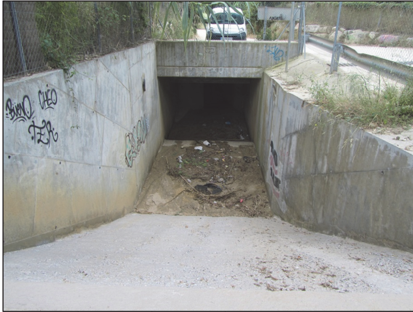
Figura 92. Entrada del soterrament de la riera de l'Aubó o Buscarons.
