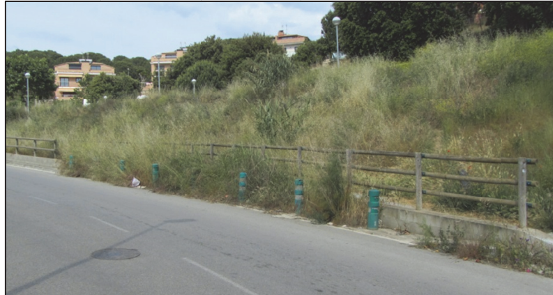
Figura 96. Final de la canalització del rial de Lladoners
