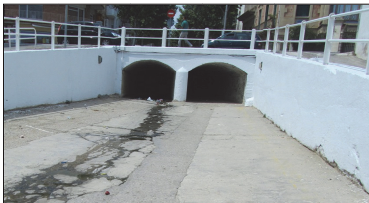
Figura 93. Sortida del soterrament de la riera de Sant Domènech.
