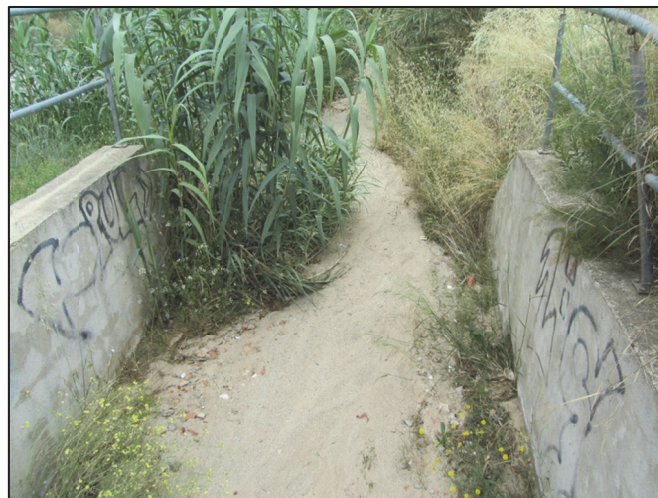
Figura 99. Inici de la canalització del rial de Can Segarres.
