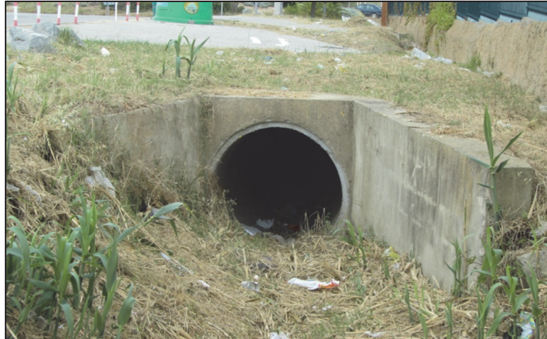
Figura 98. Entrada del soterrament del rial de Sant Crist
