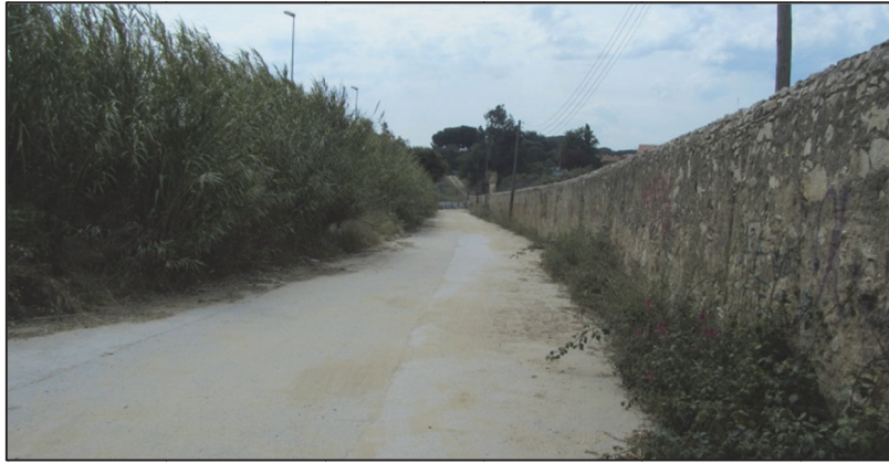
Figura 85. Rial de Cal Misser aigües avall del sorrer de l'estructura M10.
