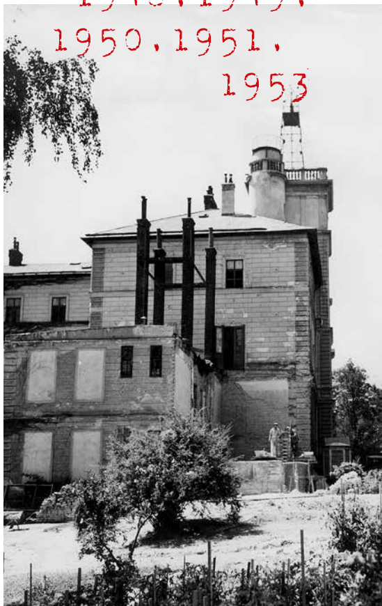
Am 9. November 1944 und am 20. Februar 1945 erlitt das Hauptgebäude der Zentralanstalt schwere Bombentreffer und im April 1945 deutsche Artillerietreffer, Ansicht des kriegsbeschädigten Hauses, Juli 1946 (ZAMG)
