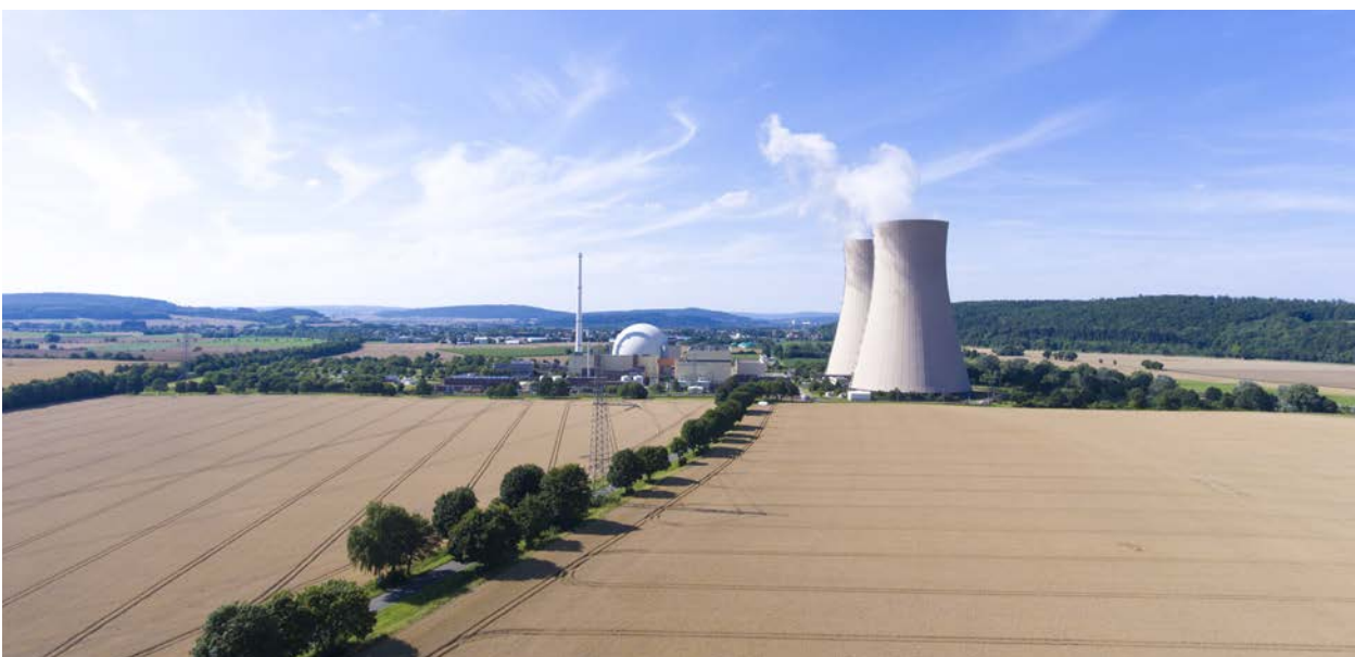
Grohnde NPP (Image: PreussenElektra)
