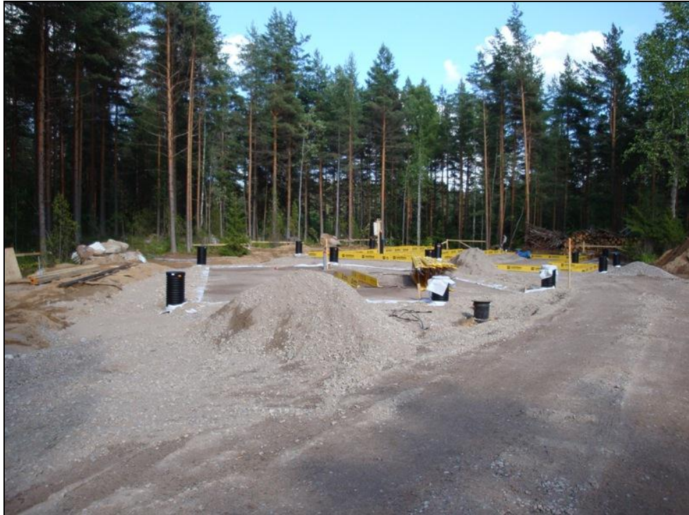
KUVIO 14. Maanrakennusvaiheen kuva kesältä 2009
