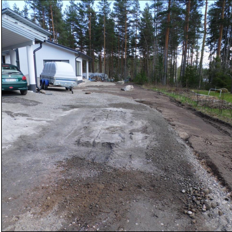
KUVIO 15. Pihan maanrakennustöiden alkuvaihetta
