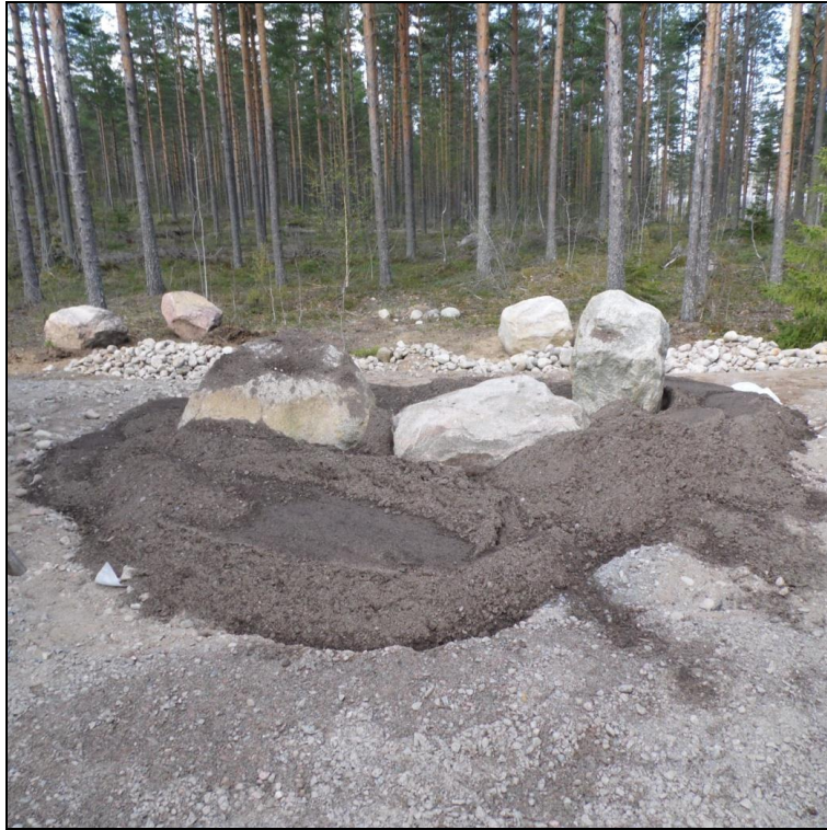
KUVIO 17. Osa maisemointiin säästetyistä kivistä on aseteltu paikoilleen maanrakennustöiden yhteydessä
