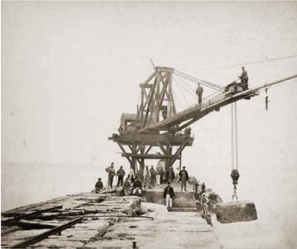
Boven de Tiantkraan die bij het bouwen van de pieren ingezet werd.
