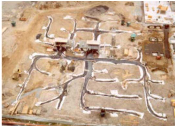
Figure 3.31 Aerial view of the Technopark de Root site, Switzerland, during the GSHPs connection operations (foto from Vinard, P. 2015. Pré-étude comparative de projets et réalisations de systèmes de stockage saisonnier. Report Etat de Geneve, Office cantonal de l’Energie (OCEN) and Office federal de l’energie (OFEN))
