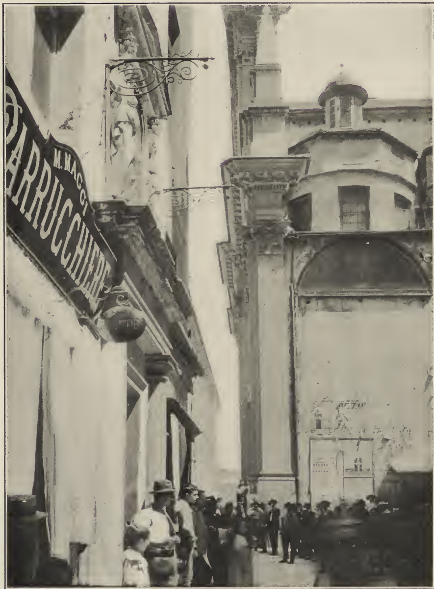
FIG. 3. THE LEANING FAÇADE OF S. AMBROGIO, GENOA.
