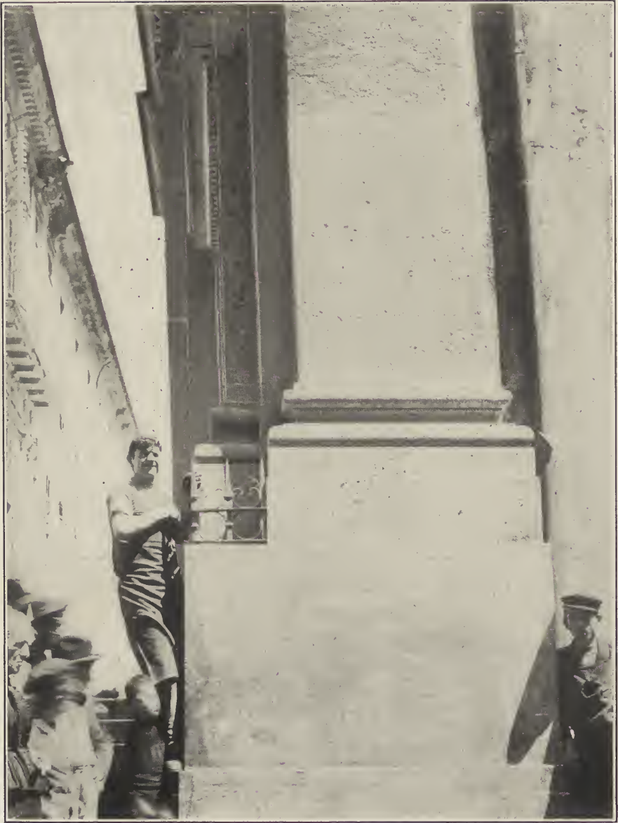
FIG. 1. THE LEANING FAÇADE OF S. AMBROGIO, GENOA.
