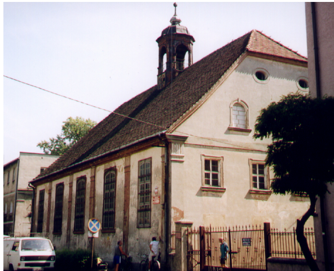
Das ehem. Bethaus der Unitäts-Brüder Bethaus, jetzt eine Schulsporthalle (Aufn. Beitragsverfasser)
