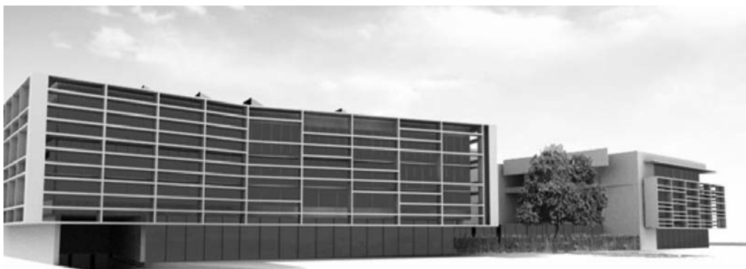
Biblioteca y Filmoteca de Navarra. Fachada Oeste al parque público.
