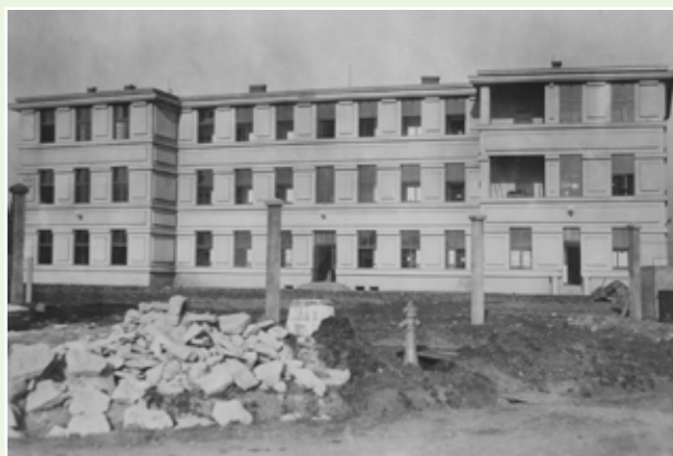
Výstavba hlavní budovy Vojenského vzduchoplaveckého studijního ústavu v Letňanech v letech 1921–1922; od roku 1922 zde sídlilo Meteorologické oddělení a od roku 1923 Meteorologická sekce
