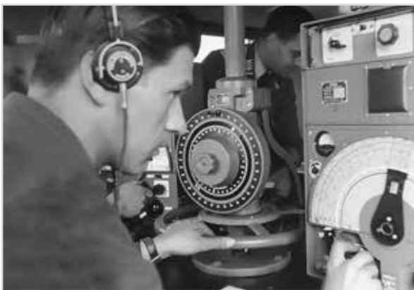
Obr. 8 Goniometrický zaměřovač EP-2a (nahore) a jeho obsluha (dole) pro provádění radiosondážních měření výškového větru (50. léta minulého století)
