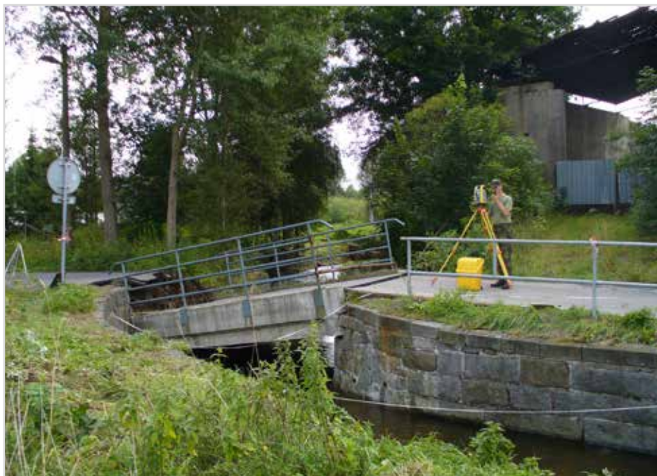
Obr. 50 Geodetické zaměření výstavby mostního provizoria na místě strženého mostu
