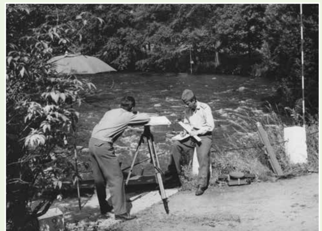
Vedle fotogrammetrických metod byla v 50. a 60. letech dvacátého století pro mapování v hustých lesích nebo roklinách stále využívána stolová metoda
