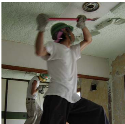
図 ケレン棒の打込み
