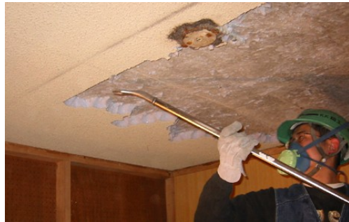
図 バールによる XPS 打込み部の分離作業
