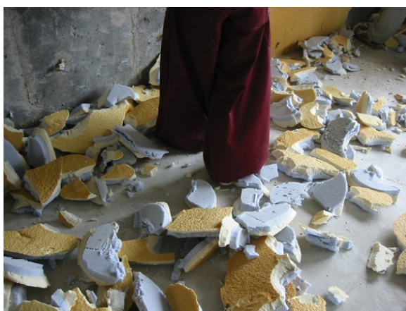
図 ケレン棒による分離断熱材片
