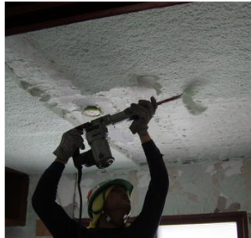
図 電動ピックによって断熱材が分離する瞬間
