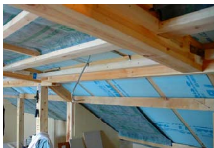
押出法ポリスチレンフォーム (住宅の屋根への施工例)
