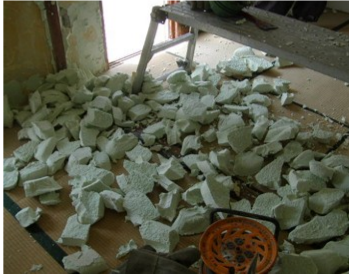
図 電動ピックによる分離断熱材片
