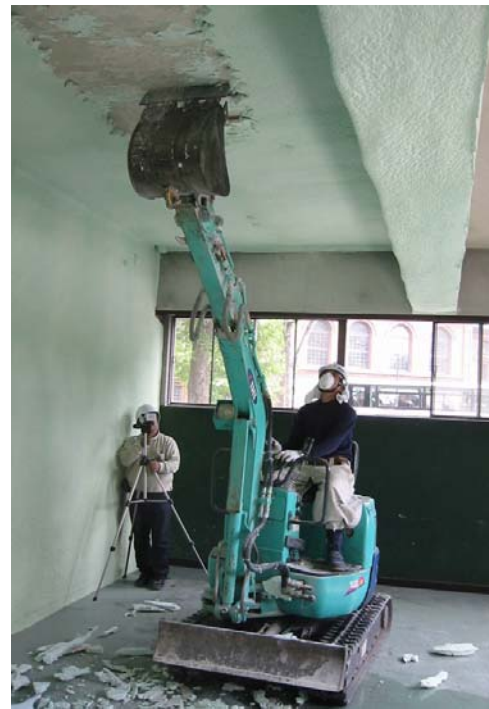
図 重機による断熱材の分離作業 (天井面)
