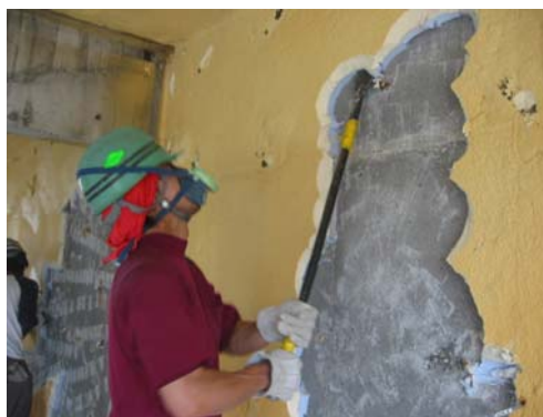
図 ケレン棒の打込み
