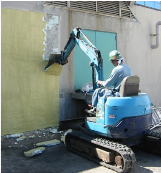
図 重機による断熱材の分離作業 (壁面)
