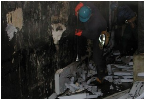
図 バールによる XPS 後貼り部の分離作業
