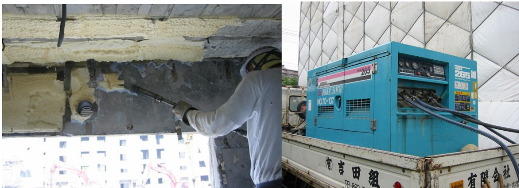
図 エアークンプレッサーを使用した断熱材の分離作業
