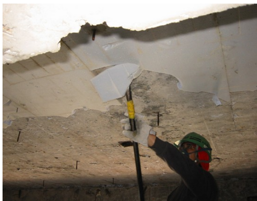
図 ケレン棒による断熱材の引き剥がし
