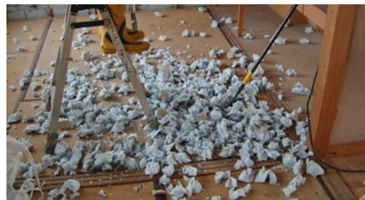
図 バールによる分離断熱材片 (XPS 打込み)
