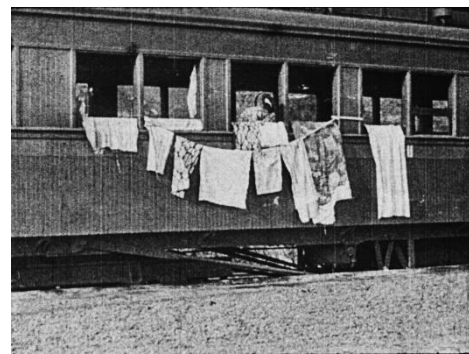
場所：静岡県／シーン：避難生活の場 東海道本線駿河駅（現・御殿場線駿河小山駅）で避難所になったという蒸気機関車。
